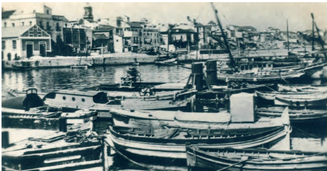
La dársena de Villanueva en 1930. Véanse la barcaza de buzos, numerosos botes y otras embarcaciones particulares atracadas. A la izquierda de la imagen, el edificio que, hacia 1925, sustituyó al desaparecido tinglado de la Pescadería.
