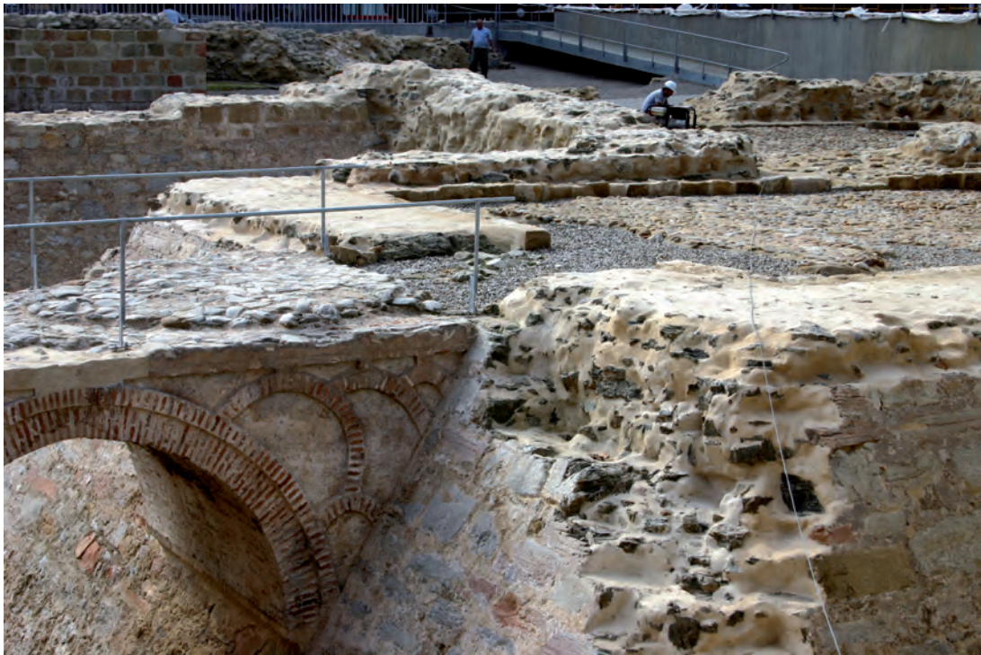
Parte del puente, el vano de entrada a la torre-puerta y el primer patio después de la restauración.
