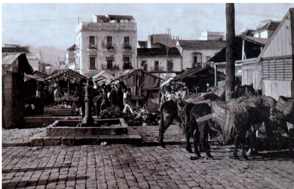
La fuente del Mercado o de la Plaza Baja en una fotografía de principios del siglo XX. Véase el deterioro que presentaban las casetas de venta en esos años.
