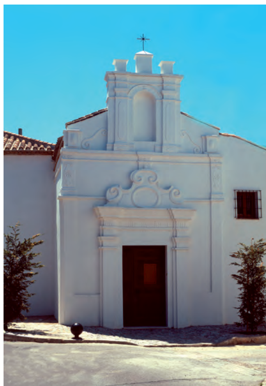
Fachada de la Capilla del Santo Cristo de la Alameda después de su restauración realizada en el año 2002.
