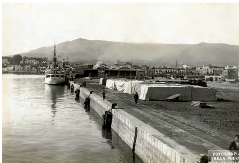
La prolongación del muelle de la Galera casi finalizada en el año 1930. Atracados junto a la Estación Marítima se hallan los vapores-correos “Miguel Primo de Rivera” y “General Sanjurjo.” (Archivo Fotográfico de la A. P. B. A.).
