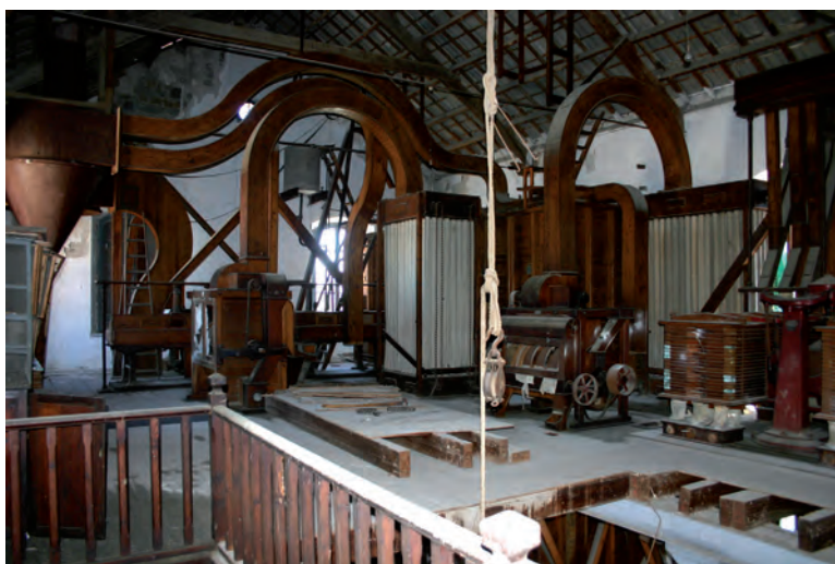
La tercera planta del edificio principal con algunos de los elementos empleados en las labores de molienda de los cereales situados encima de los molinos trituradores de la marca Bühler que se ubicaban en la planta intermedia.
