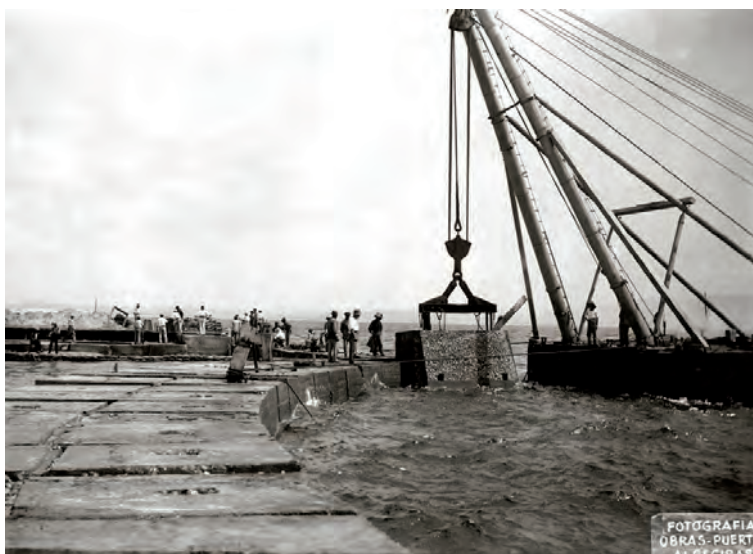
La grúa holandesa Adelaar colocando un bloque en el morro del Rompeolas a mediados de 1932. (Archivo Fotográfico de la A. P. B. A.).
