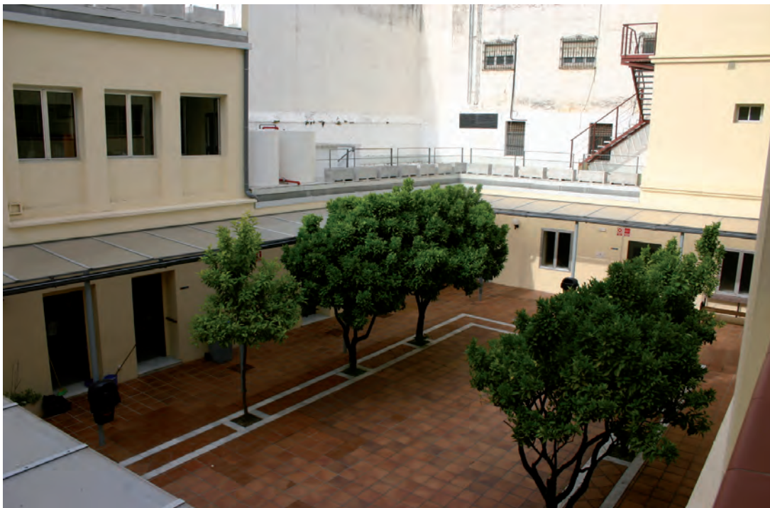
Patio trasero del antiguo Hospital Militar de Algeciras ampliado en la reforma de 1996 y sembrado de naranjos, recordando el aspecto que debió tener en los siglos XVIII y XIX cuando se hallaba ajardinado.
