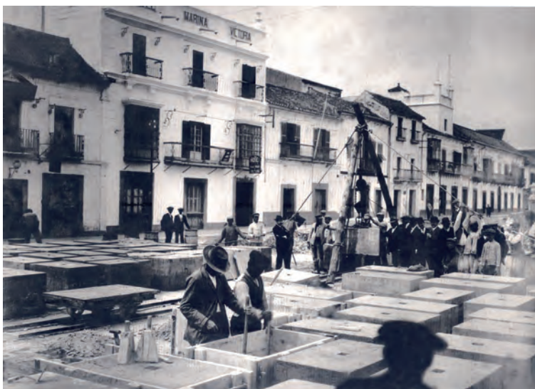
Construcción de bloques para las obras de ensanche del muelle Comercial o Viejo. Año 1913. (Archivo Fotográfico de la A.P.B.A.).
