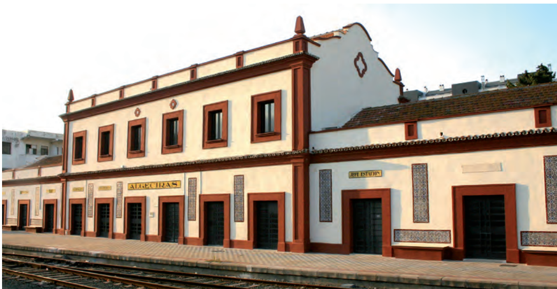
La antigua Estación del Ferrocarril después de la restauración a que fue sometida entre los años 2010 y 2011.
