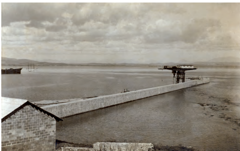
Las obras del Rompeolas a principios de 1923. (Archivo Fotográfico de la A. P. B. A.).
