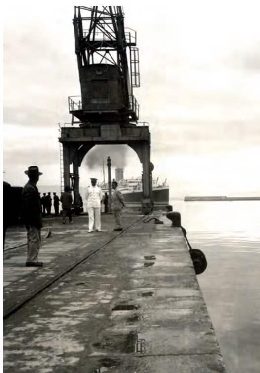
La grúa eléctrica procedente del puerto de Motril montada en el lado sur del muelle de la Galera en 1956 (Archivo Fotográfico de la A. P. B. A.).
