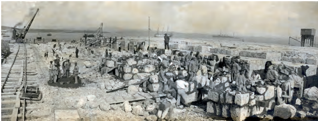
Construcción de bloques de mampostería en el Taller de la Isla Verde utilizando sillares y sillarejos de piedra caliza procedente de la Cantera de los Guijos. En torno al año 1924. (Archivo Fotográfico de la A. P. B. A.).
