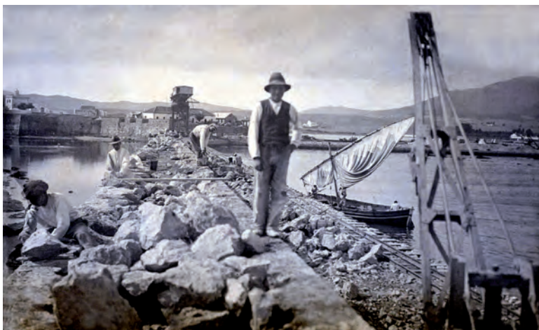
Las obras del Rompeolas en 1922. Véanse al fondo de la imagen, el Titán recién instalado y la muralla del Fuerte de la Isla Verde. (Archivo Fotográfico de la A. P. B. A.).
