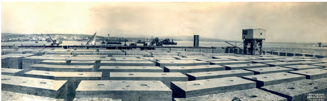
El Taller de Bloques de la Isla Verde en 1930. Véanse los grandes bloques de 80 y 90 toneladas de mampostería, al fondo de la imagen, y los de hormigón en primer plano. (Archivo Fotográfico de la A. P. B. A.).
