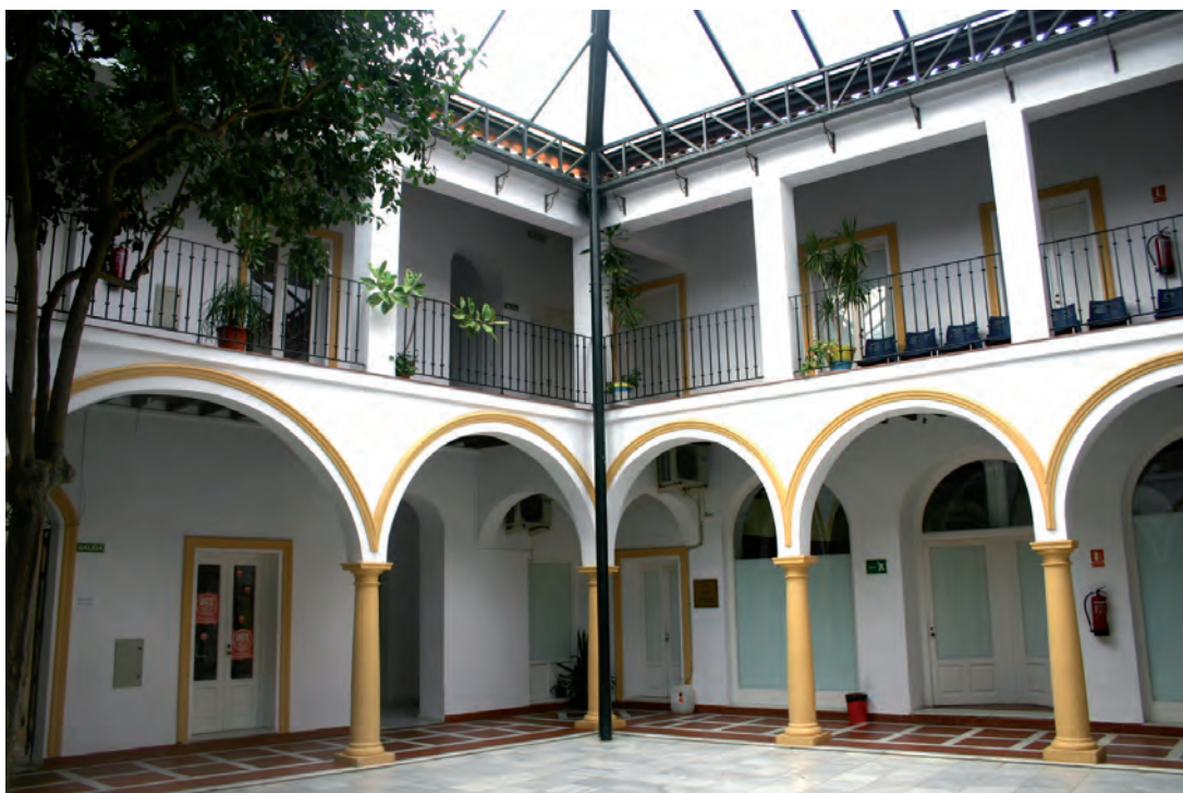
El patio y galerías del antiguo edificio de la “Escuela de Artes y Oficios”. Fotografía tomada en el año 2012.
