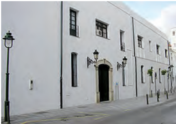
Fachada del Hospital de la Caridad que da a la calle Teniente Farmacéutico Miranda y puerta principal remodelada en 1930 según consta en la clave de la misma.
