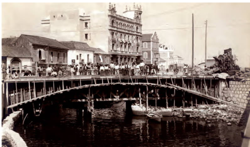
Obras de construcción del nuevo puente de la Conferencia. Año 1924 (Archivo Fotográfico de la A.P.B.A.).
