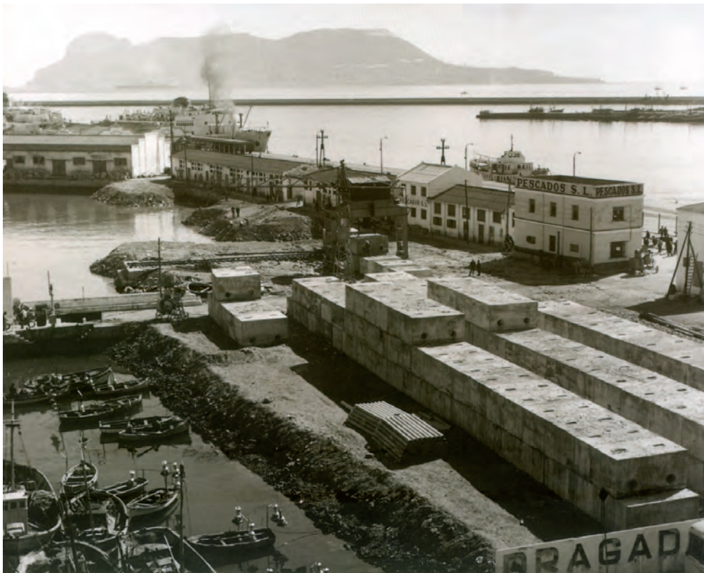
Obras de ensanche del tramo inicial del muelle de la Galera y relleno total de la dársena de Villanueva para habilitar un gran espacio frente a la acera de la Marina. Año 1963. (Archivo Fotográfico de la A.P.B.A.).
