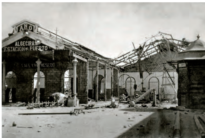
Demolición parcial de la vieja Estación Marítima para proceder a su reforma y ampliación. Año 1950 (Archivo Fotográfico de la A. P. B. A.)
