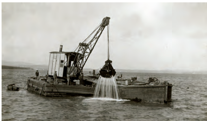
Draga de cuchara trabajando en las obras de dragado del muelle de la Galera hacia 1920. (Archivo Fotográfico de la A. P. B. A.).
