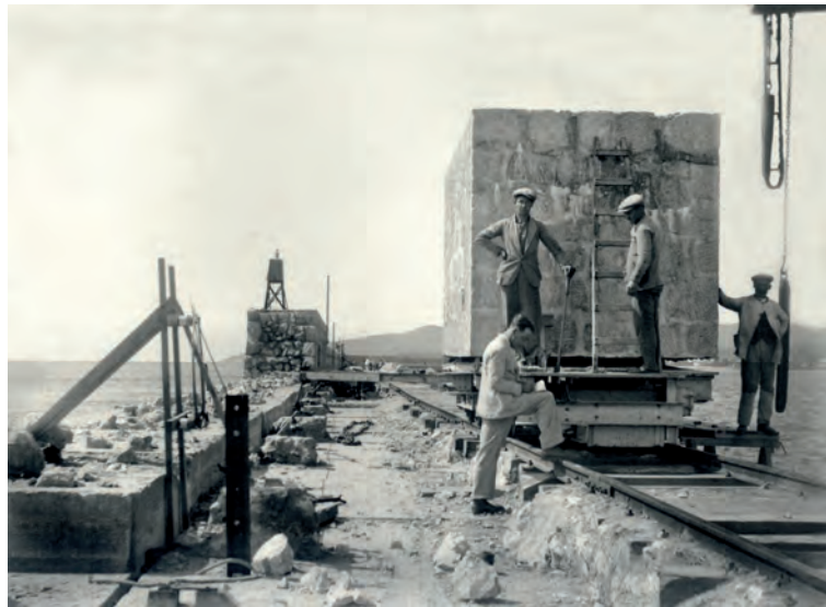
El carro trasbordador portando un bloque sobre las vías del Titán hacia 1926. (Archivo Fotográfico de la A. P. B.A.).
