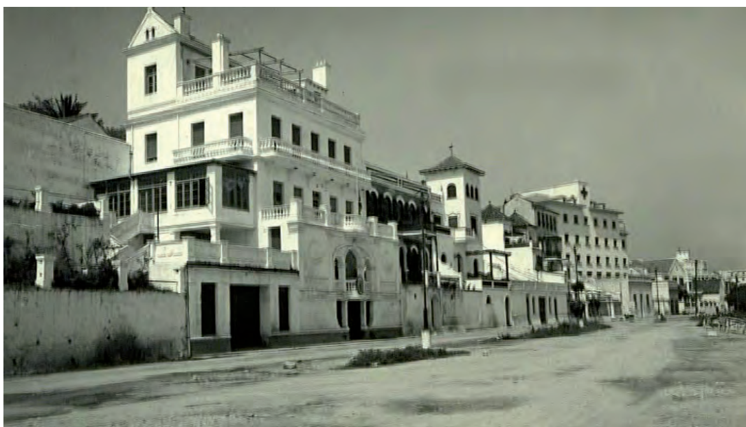
El Paseo de la Conferencia hacia 1953. Las obras de la sede de la Junta de Obras del Puerto se habían acabado en ese año, quedando el edificio recién construido fuera del campo de visión del fotógrafo, a la derecha de la imagen.
