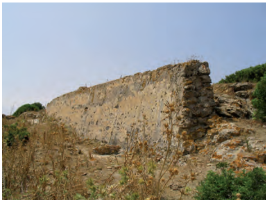
Tramo de la muralla conservado del Fuerte del Tolmo (Fotografía cedida por Ángel J. Sáez).
