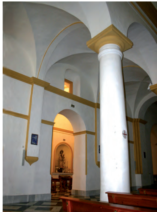
Nave del Evangelio y muro primitivo del templo.
