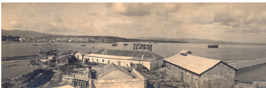
Fotografía de la Isla Verde y de la ciudad de Algeciras tomada en el año 1925. En primer plano, en el centro de la imagen, el polvorín en buen estado de conservación. Véanse los arruinados muros del fuerte en la parte izquierda de la foto y el Dique Norte en construcción (Archivo Fotográfico de la A.P.B.A.).
