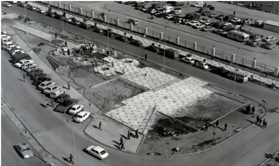
Obras de urbanización en la Plaza de la Marina realizadas en el año 1973. (Archivo Fotográfico de la A.P.B.A.).
