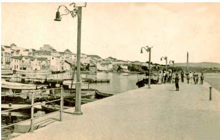
El muelle de Villanueva recién terminado en una fotografía de 1917. Obsérvese como aún no se había construido el espaldón exterior. (Archivo Fotográfico de la A.P.B.A.).
