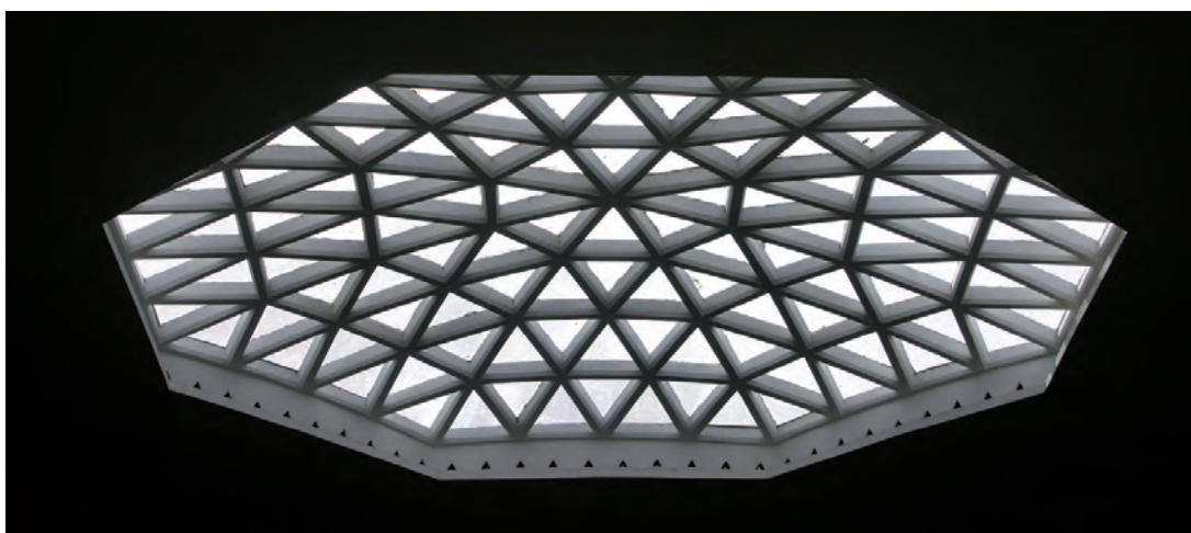
Lucernario o claraboya cenital que sustituye la inexistente clave de la bóveda que cubre el Mercado Ingeniero Torroja.
