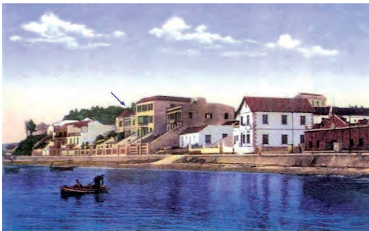
Edificio del Paseo de la Conferencia donde estuvo ubicada la Comandancia de Marina hasta el año 1963 cuando se trasladó al inmueble de la Avenida de la Hispanidad.
