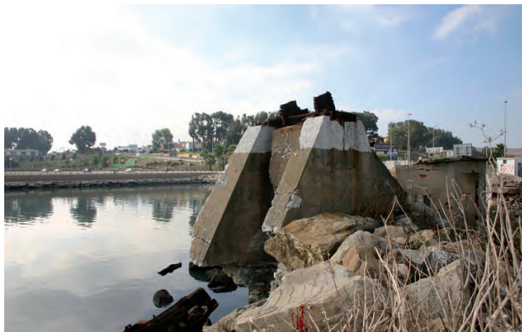
Uno de los contrapesos del puente levadizo construido en la playa del Saladillo en 1920 que aún se conserva en lo que fue Astilleros y Varaderos del Rodeo.
