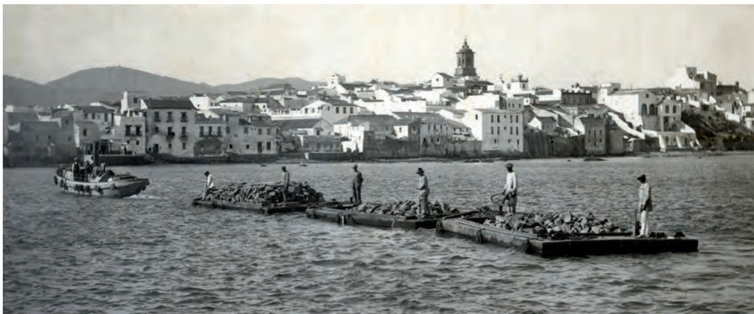
Chalanas transportando escollera para las obras del muelle de la Galera. Año 1917 (Archivo Fotográfico de la A. P. B. A.).
