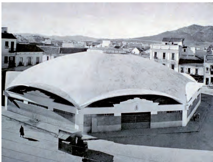
El Mercado Ingeniero Torroja recién terminado en 1935. Véase el escudo de la ciudad que en sus primeros años estuvo situado sobre el dintel de las cuatro entradas.
