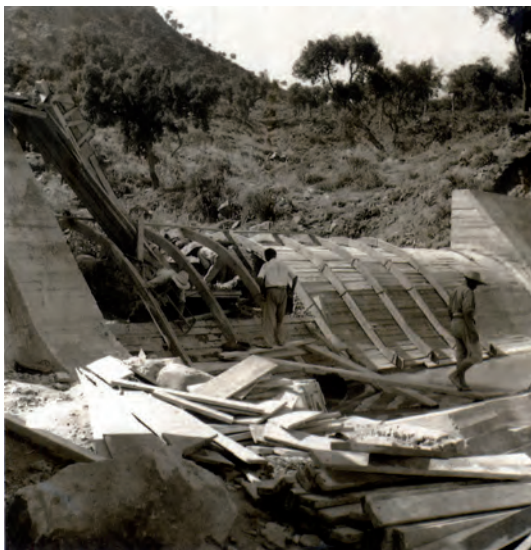
Construcción de la Presa del Cobre. Fotografía tomada en 1953. (Archivo Fotográfico de la A.P.B.A.).
