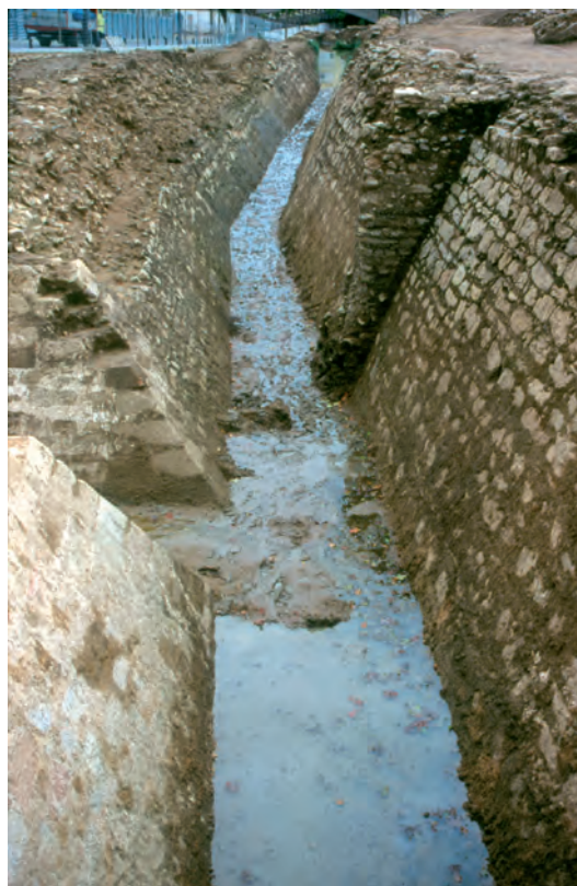
Vista parcial del foso.
