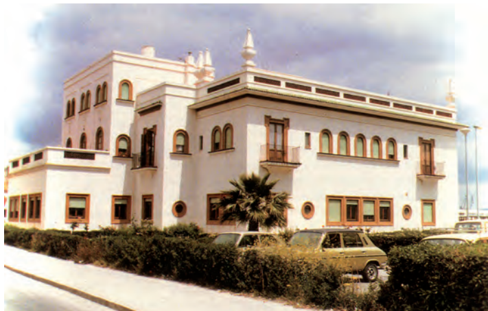
Vista lateral del edificio de oficinas de la Junta con los cuerpos añadidos en sus fachadas norte y sur. Fotografía realizada hacia 1980 (Archivo de la A.P.B.A.).
