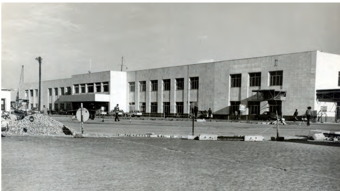
La nueva Estación Marítima una vez terminada y ejecución de trabajos de urbanización en su entorno. Año 1972 (Archivo Fotográfico de la A. P. B. A.).
