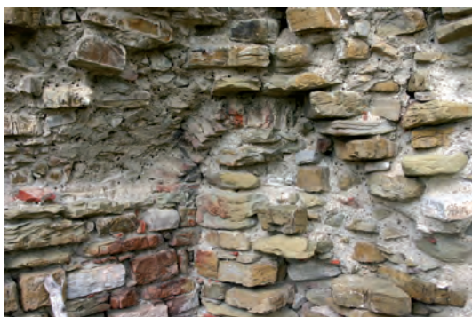
Restos de la bóveda de ladrillos que cubría la escalera que daba acceso al sótano.
