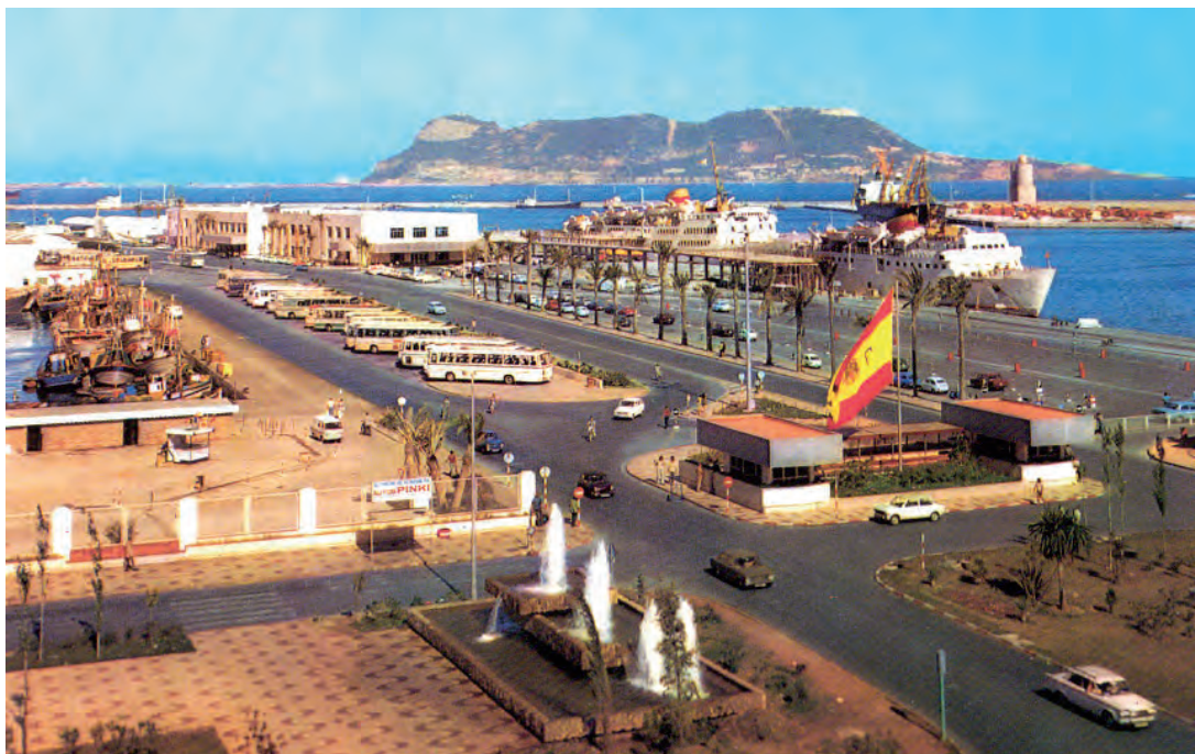
El muelle de la Galera en 1975 después de las reformas acometidas en el mismo y en sus entornos entre los años 1969 y 1974, entre ellas la urbanización de la Plaza de la Marina, en primer término.
