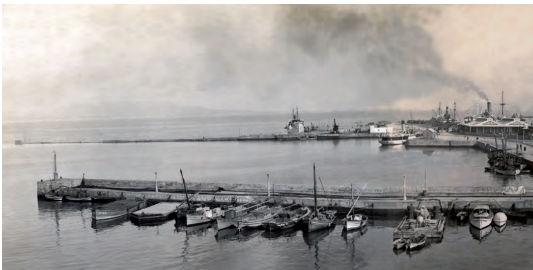
En primer término, el muelle y la dársena de Villanueva y, más lejos, el muelle Pesquero en construcción. Fotografía tomada en 1935. (Archivo de la A. P. B. A.).
