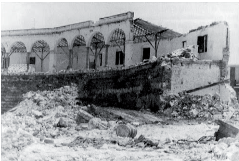
Demolición de la plaza de toros “La Perseverancia” en la primavera de 1975.
