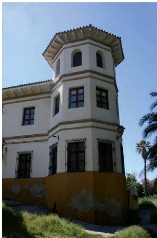
Torre-mirador situada en el ángulo sureste de la casa-palacio. Véase el alero con las falsas cabezas de vigas.
