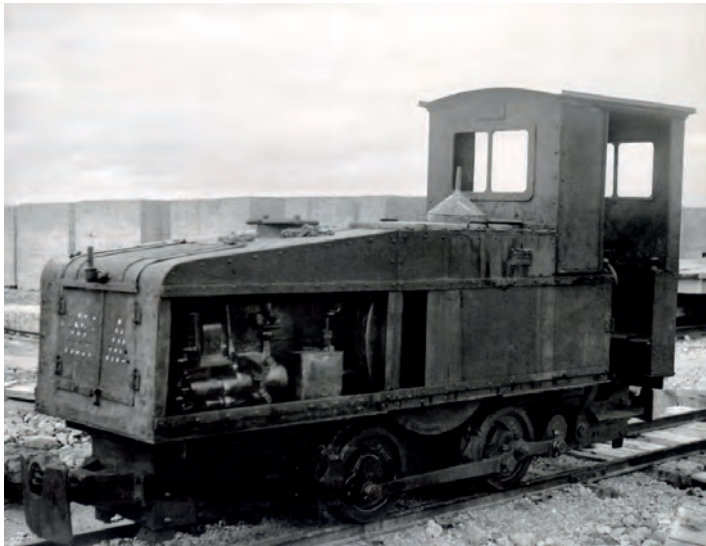
Una de las dos máquinas de benzol que fueron adquiridas por la Junta de Obras del Puerto en 1920 para el transporte de piedras desde la Cantera de los Guijos fuera de uso. En torno a 1930. (Archivo Fotográfico de la A. P. B. A.).
