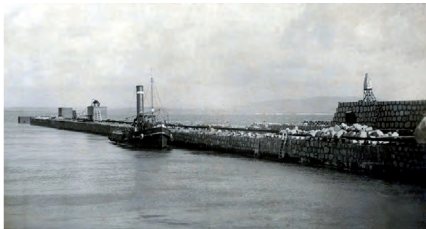
Las obras del Rompeolas de la Isla Verde en 1921, antes de la llegada de las grúas Goliath y Titán. Véase el espaldón a la derecha de la imagen. (Archivo Fotográfico de la A. P. B.A.).
