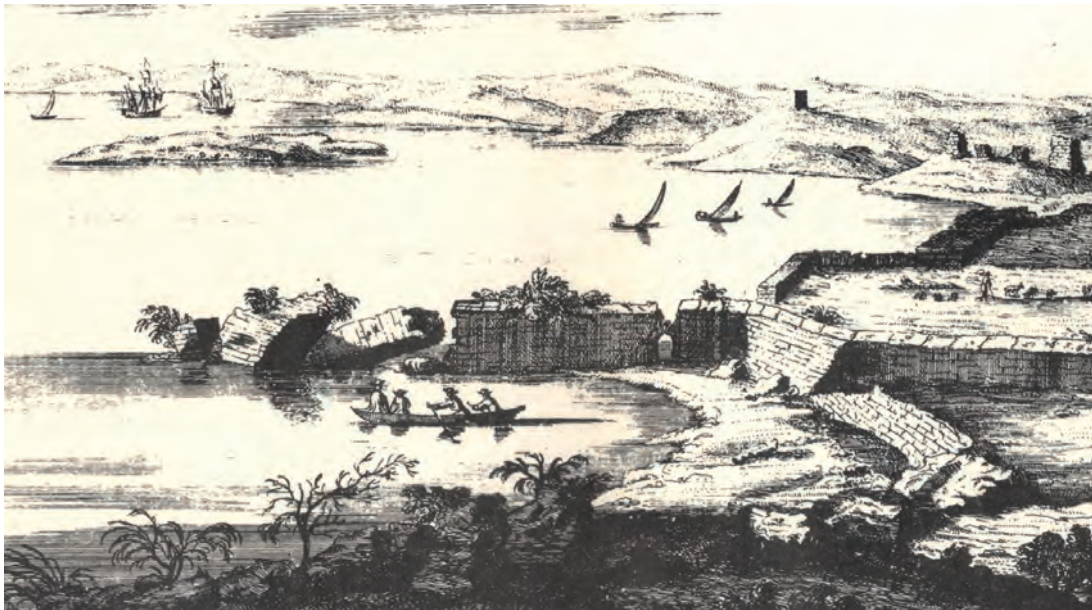
La coracha y la torre marítima existentes en el ángulo nordeste de la muralla, en la prolongación de la actual Avenida Blas Infante. Véase la puerta abierta en la coracha y, al fondo, la Isla Verde. Fue demolida a finales de los años cuarenta para construir el muro de Ribera o Paseo Marítimo. (Grabado inglés de la segunda década del siglo XVIII).
