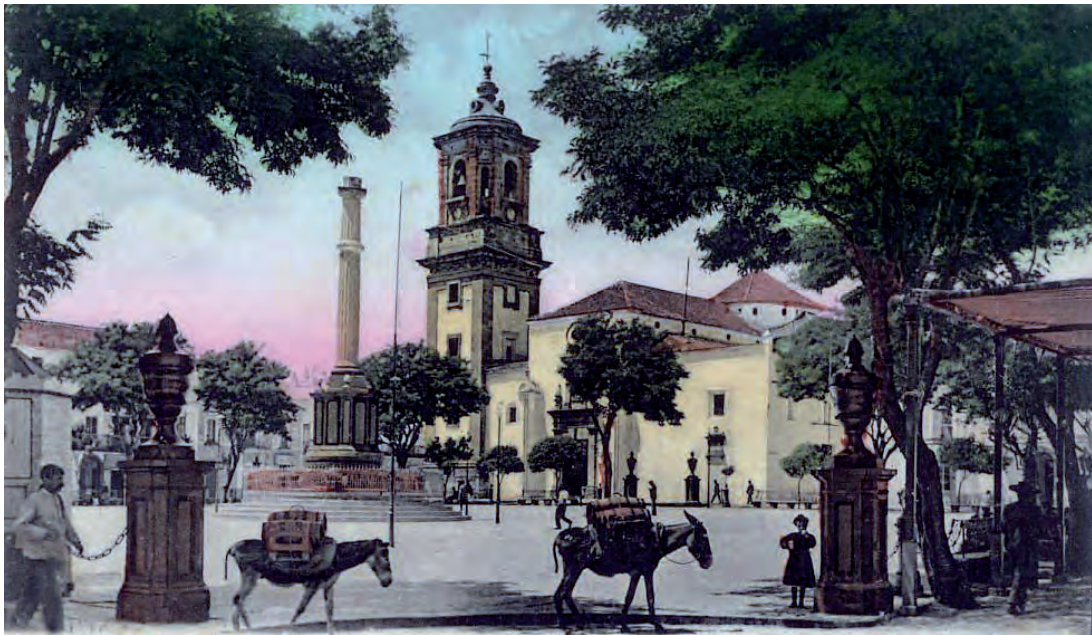
Fotografía coloreada de la Plaza Alta tomada en 1905. En primer plano los pedestales rematados con los vasos de tipo etrusco y las cadenas que fueron suprimidas en el año 1918. En segundo plano el monumento central con la fuente con basamento de gradas circulares y la columna.
