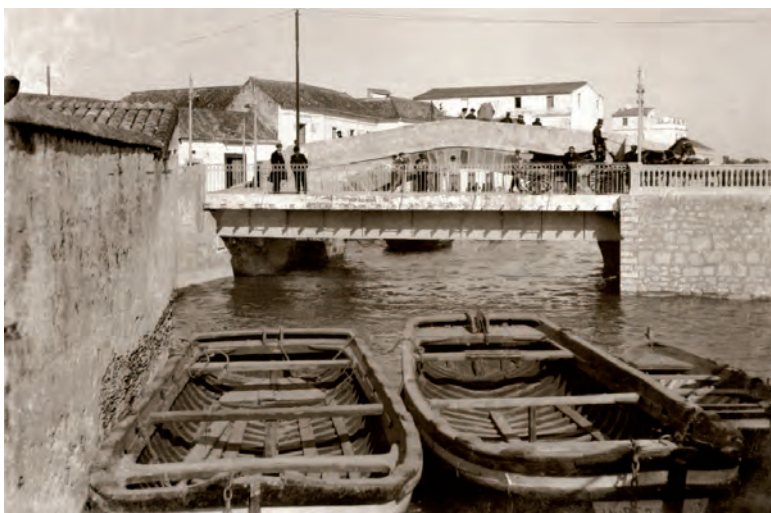
El puente de la Conferencia, construido entre noviembre de 1905 y enero de 1906. Detrás puede verse el puente Viejo (Fotografía cedida por José Luis de los Ríos).
