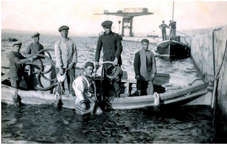
Uno de los buzos que trabajaron en las obras del Rompeolas junto al bote de apoyo. Al fondo se puede ver el Titán. Hacia 1929. (Archivo Fotográfico de la A. P. B. A.).
