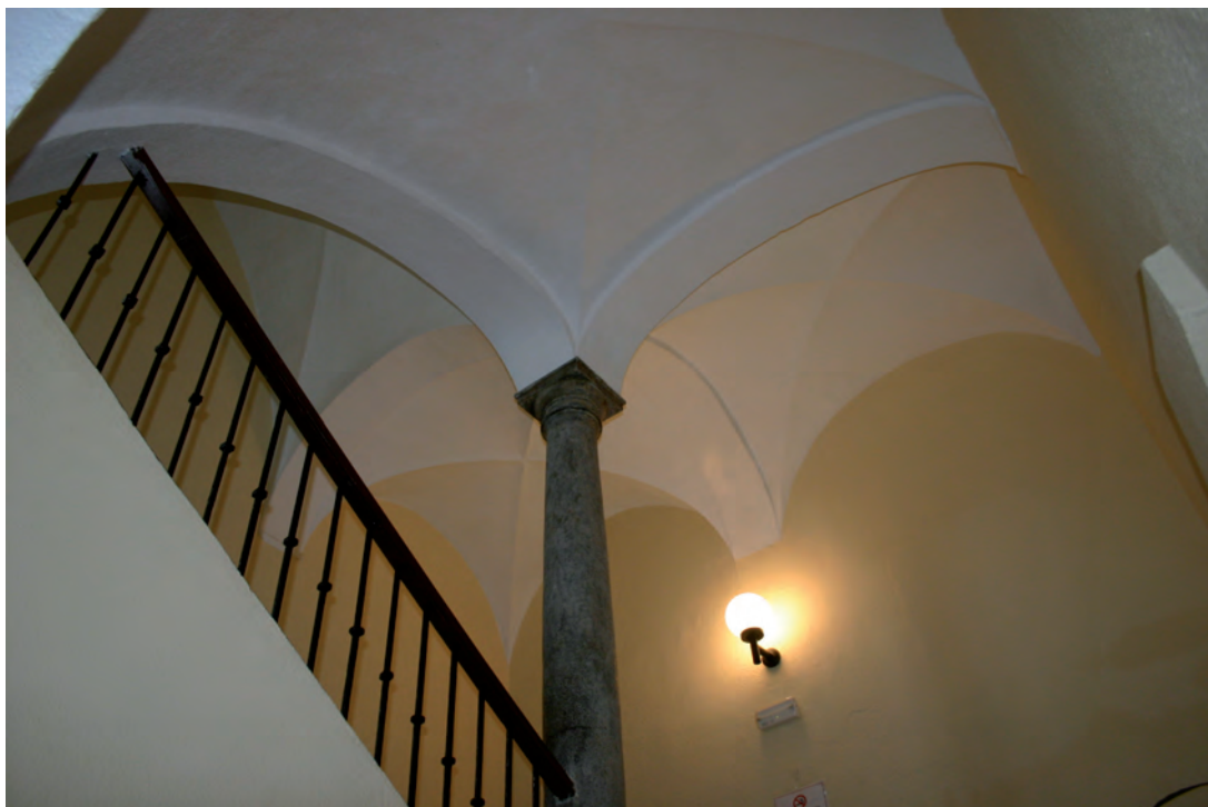
La escalera principal del edificio es, sin duda, el elemento más característico y de más destacados valores arquitectónicos de los conservados. Se articula en dos tramos y se cubre con elegantes bóvedas de arista.
