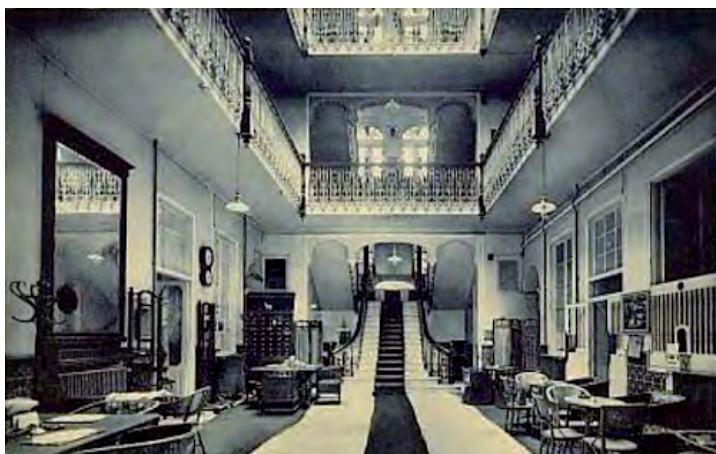
Una vista del hall del Hotel Anglo-Hispano tomada desde la entrada al mismo. Al fondo se puede ver la magnífica escalera que daba acceso a las plantas superiores donde se hallaban situadas las habitaciones.
