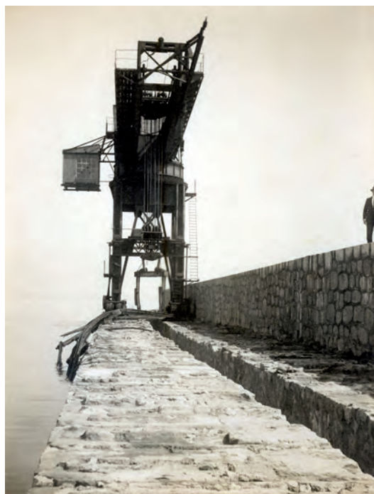
Daños causados en las vías del Titán por uno de los temporales sufridos en el invierno de 1925. (Archivo Fotográfico de la A. P. B. A.).
