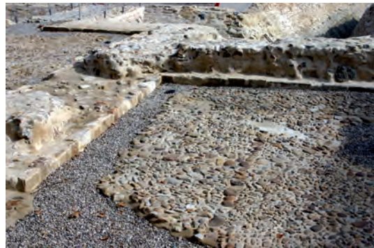
El segundo patio con parte del empedrado original conservado. Obsérvense los muros con núcleo de calicanto y revestimiento de sillares.
