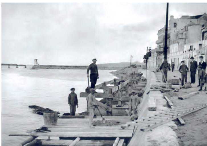
Construcción de la plataforma para la colocación de las vías del ferrocarril de obras en el Paseo de la Conferencia. Al fondo, el puente de la Isla Verde casi finalizado. Año 1926. (Archivo Fotográfico de la A. P. B. A.).
