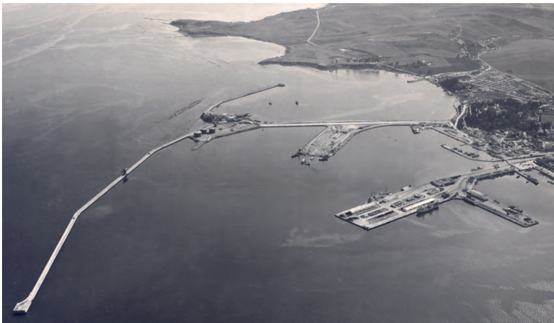
Fotografía aérea realizada en 1964 en la que se puede observar el inacabado muelle de Pasajeros, los Diques Norte y Sur, los muelles de la Galera y Pesquero y la carretera de acceso a la Isla Verde. (Archivo Fotográfico de la A. P. B. A.).
