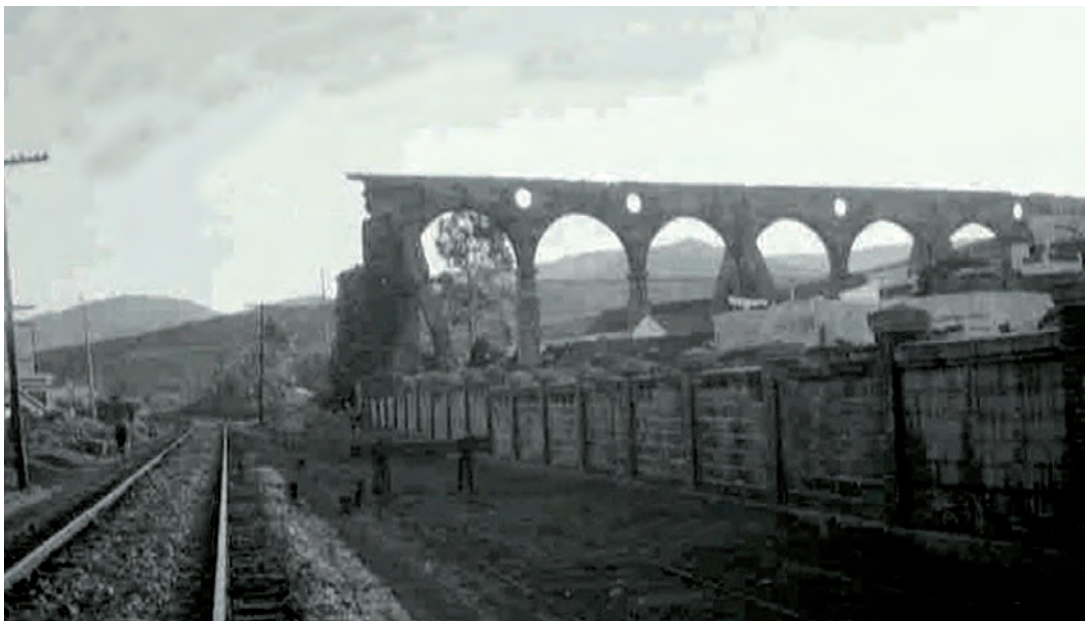
Fotografía tomada en el mes de diciembre de 1958, unos días después del derrumbe de los tres arcos centrales del acueducto a causa de un temporal de viento y lluvia, suceso que aconteció en el noche del 16 de diciembre de aquel año.
