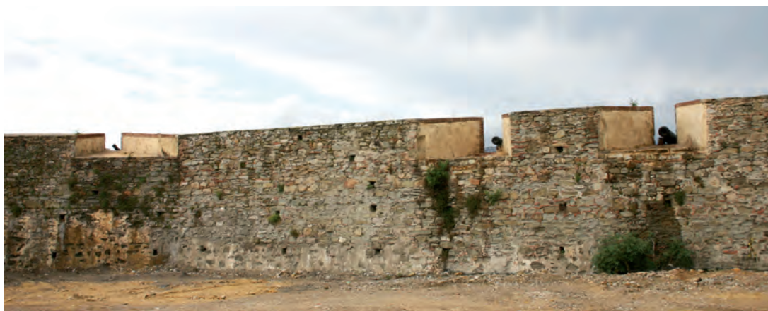
El Fuerte de la Isla Verde. Fachada nordeste en la actualidad con las troneras restauradas y los cañones.
