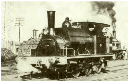
Locomotora "Jimena" que se utilizó en los trabajos de tendido de la línea en el tramo entre Algeciras y Jímena.
