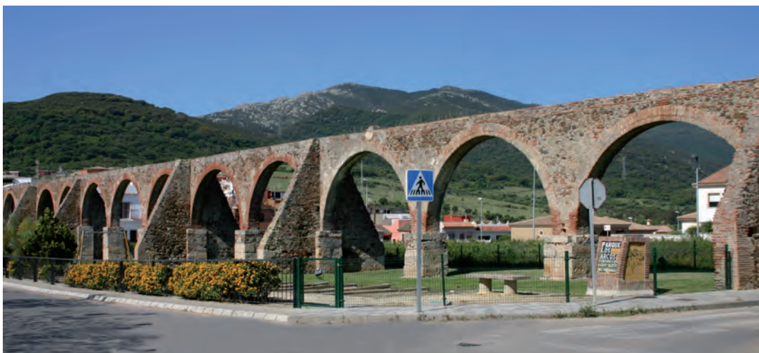
Tramo del acueducto construido entre 1841 y 1845 en la barriada del Cobre en la actualidad.
