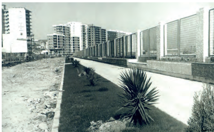
Construcción de la verja de separación entre el Paseo Marítimo y “Llano Amarillo.” Año 1971 (Archivo de la A.P.B.A.).
