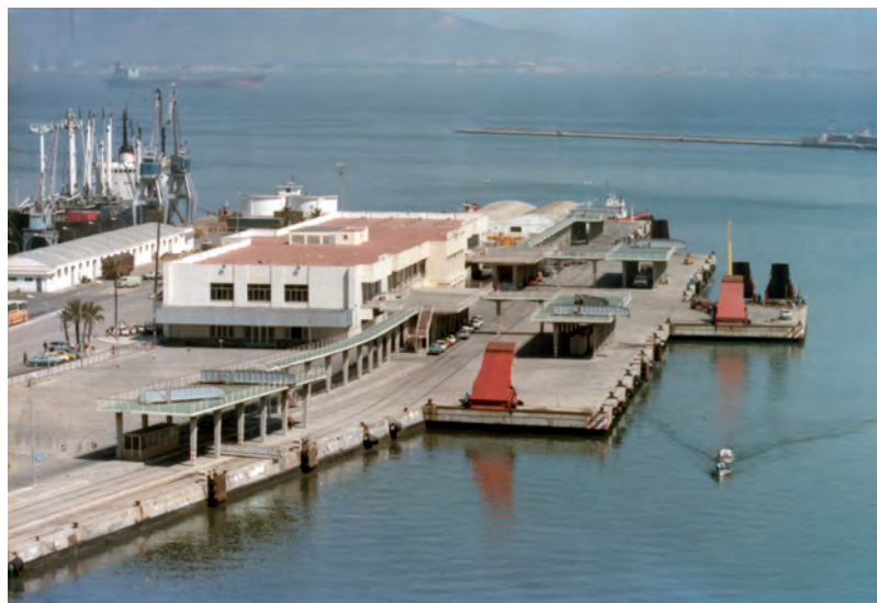
La nueva Estación Marítima y los atraques construidos para los transbordadores de Ceuta y Tánger. Año 1980. (Archivo Fotográfico de la A. P. B. A.).
