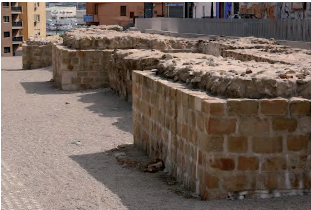
Lám. 60.- Torres de flanqueo en la Prolongación de la Avenida Blas Infante después del proceso de restauración. Obsérvese el núcleo de cal y canto y el revestimiento de sillares.
