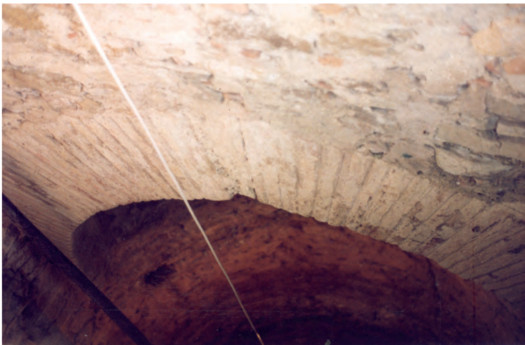
Lám. 30.- Bóveda del pozo de noria de época musulmana existente en los jardines del Hotel Reina Cristina de Algeciras.
