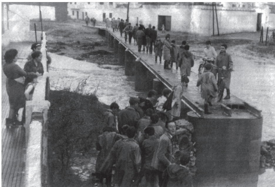
Puente de mampostería que Rosendo, el propietario del bar Las Vegas, construyó para facilitar el paso entre una y otra orilla del río cuando las crecidas del caudal inutilizaban las inseguras pasaderas. Fotografía tomada en torno al año 1963.
