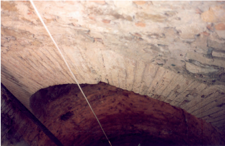
Bóveda del pozo de noria existente en los jardines del Hotel Reina Cristina que debió servir para abastecer de agua a una mezquita o a uno de los baños de al-Binya .
