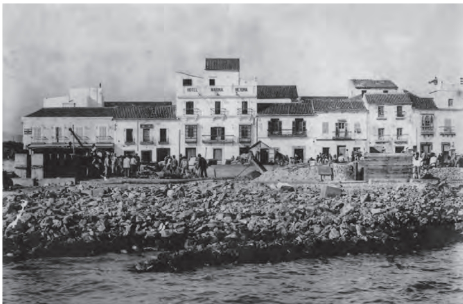
Obras de relleno en la construcción del muelle de la Galera, primera fase, en 1914-1915. En el centro de la imagen el Hotel Marina Victoria y la futura Marina (Archivo Fotográfico de la A. P. B. A.).
