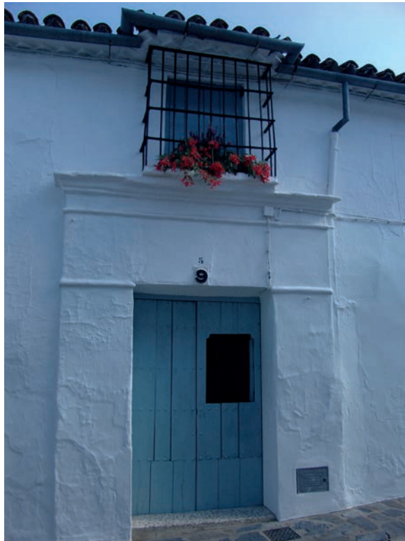
Lámina 20: Fachada de casa tradicional de Jimena. El “soberao” en la parte alta
