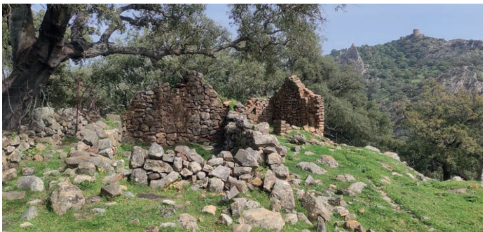
Lámina 16: Casa abandonada en la ladera de Capucho. En aquellos tiempos campesinos, braceros y jornaleros pululaban por los campos y montes de Jimena
