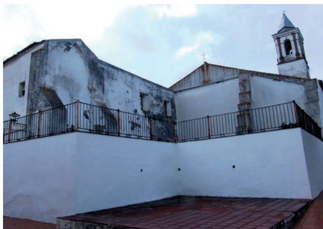
Lámina 19: La ermita invisible. Aquí se localizaba en el siglo XVI la original ermita de Santa Ana y después la cabecera gótica del convento de la Victoria. 151
