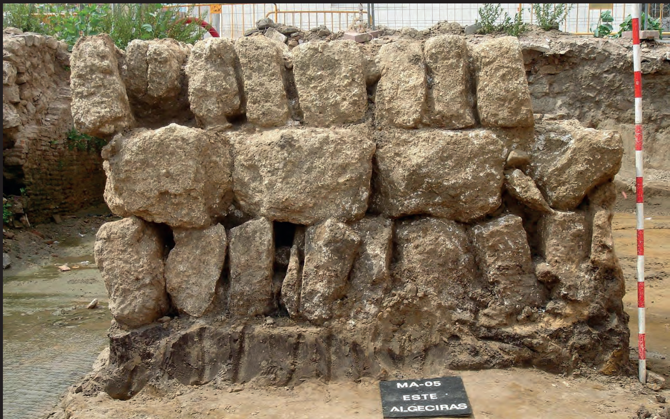
Aparejo califal a soga y tizón de uno de los pilares de las atarazanas, donde fueron localizadas por el arqueólogo Salvador Bravo en la esquina de la avenida de la Marina con la calle Segismundo Moret, en 2006
