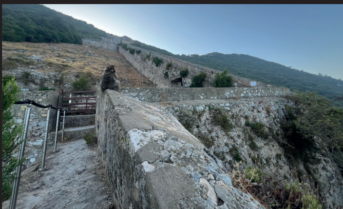
Lámina 73.-Camino de ronda de la Muralla de Carlos V
