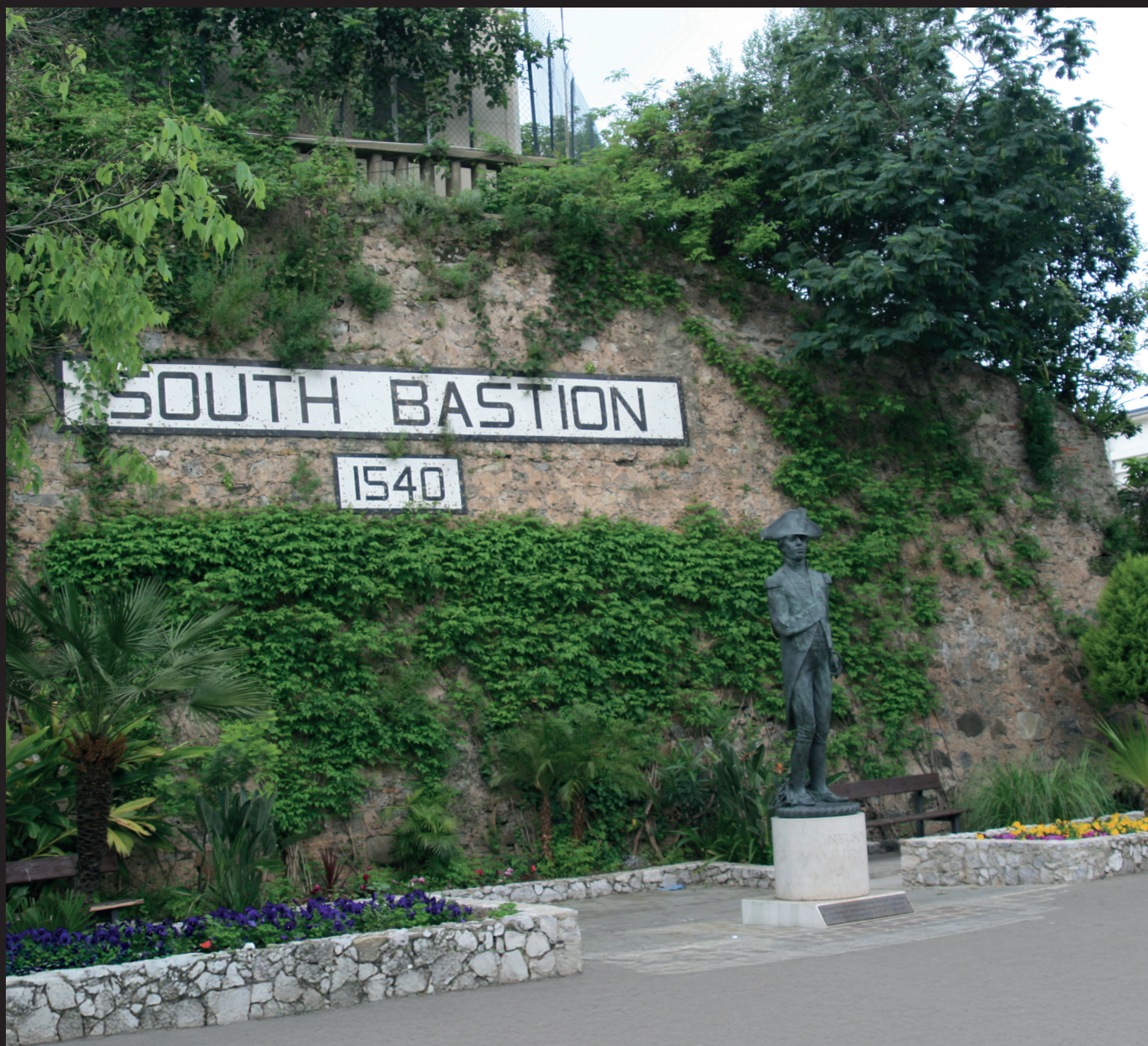
Lámina 69.- Flanco este del prácticamente desaparecido Baluarte de Ntra. Sra. del Rosario, que fue convertido en South Bastion en época inglesa
