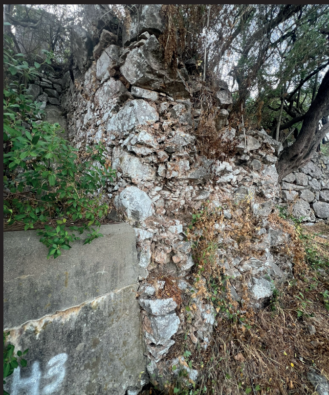
Lámina 43.- Detalle de los restos de la Muralla de San Raimundo en el English Way
