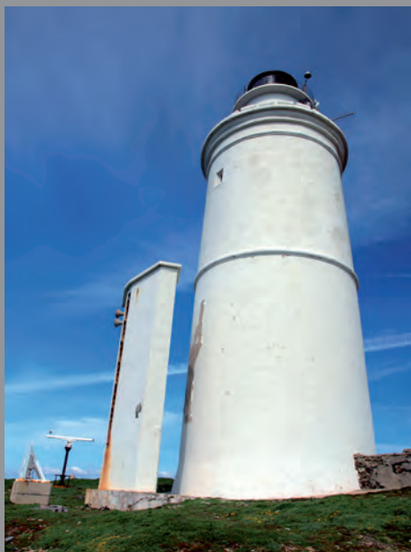
Faro de Tarifa, situado en Punta Marroquí. Se construyó reformando la antigua Torre de la Almenara. La moldura indica la antigua altura de la torre y la estructura que se añadió por encima.
