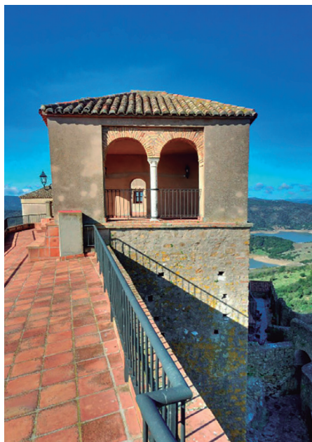
Mirador con cubierta de tejas árabes a cuatro aguas y ventanas ajimezadas de ladrillo que remata la antigua torre del Homenaje, obra del siglo XIX anterior a 1839.
