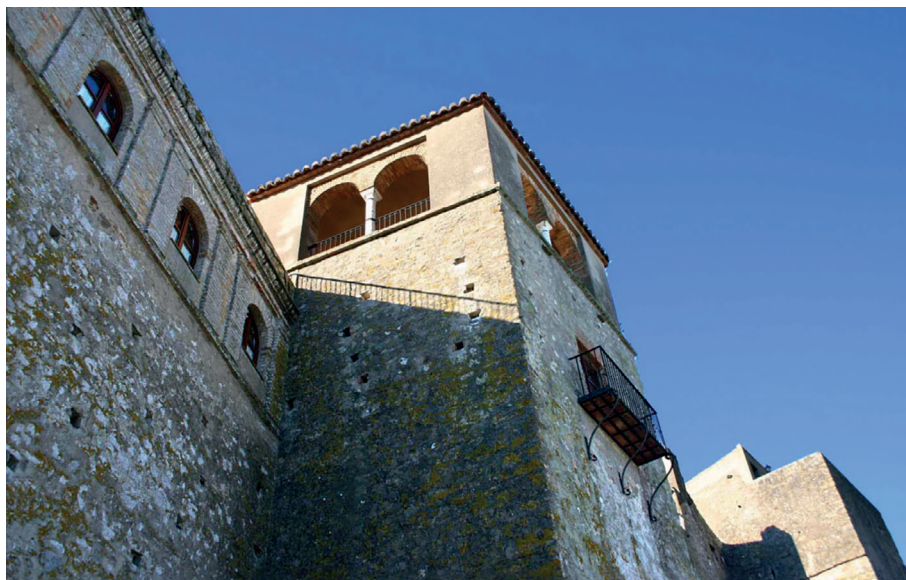
Torre del Homenaje del alcázar de Castellar, muy desfigurada por el recrecido del edificio adjunto, el balcón abierto en su fachada norte y el remate con grandes ventanales ajimezados y la cubierta de tejas a cuatro aguas, obras del siglo XIX.
