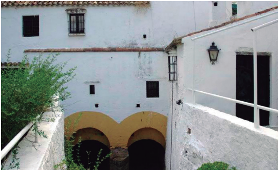
En primer término el canal o «cao» que conducía el agua hasta el río Guadarranque después de haber movido los dos rodezños del Molino de Arroyo Dulce o del Conde que se encontraban en el interior de las alcobas o bóvedas que aparecen en la parte inferior de la imagen.
