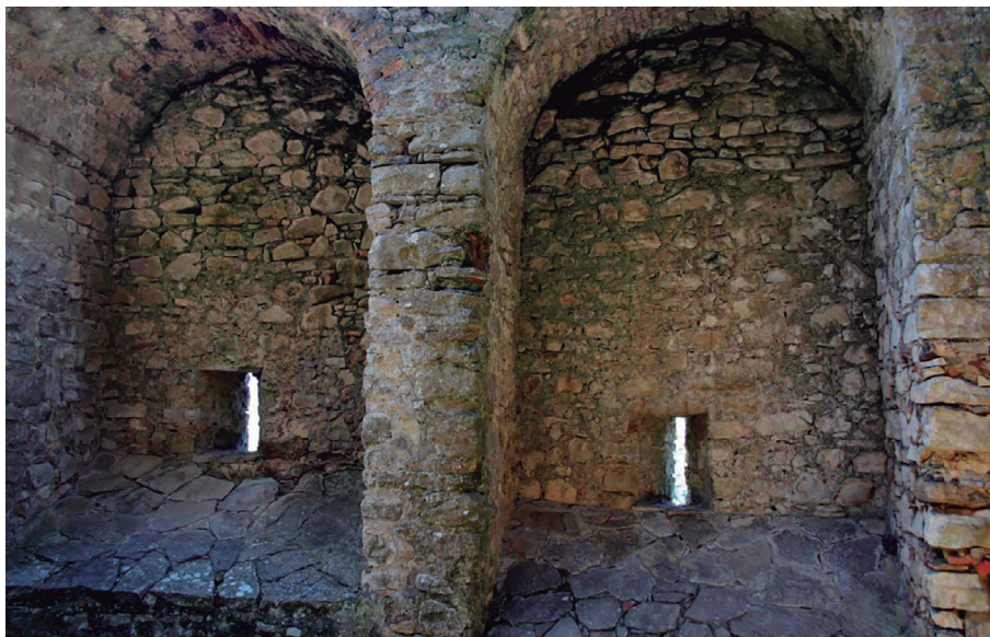
Barrera o barbacana que une las dos torres del ingreso a la villa y que fueron reforzadas, en el siglo XVI o principios del XVII, con cámaras para arcabuceros con sus respectivas troneras.
