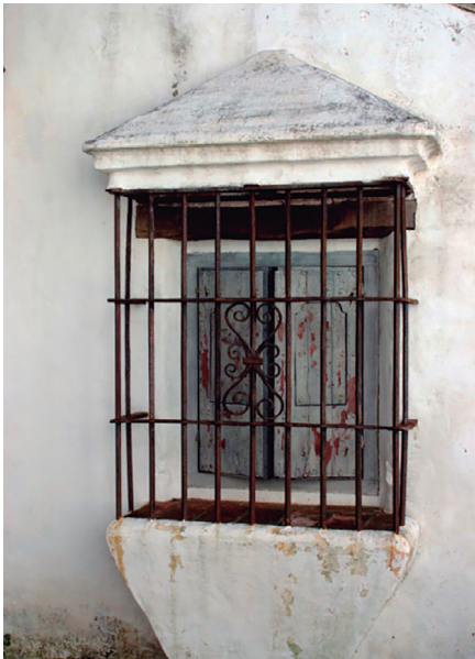
Ventana con típica reja saliente de forja con guardapolvo de mampostería y peana piramidal invertida.
