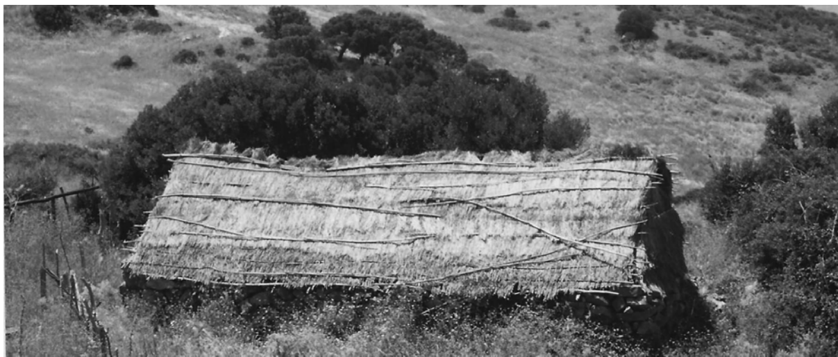
Lámina 2. Típica choza o morisco construida en los montes. Viviendas vernáculas de ámbito rural donde el maestro Pol impartía sus clases. Imagen del autor
