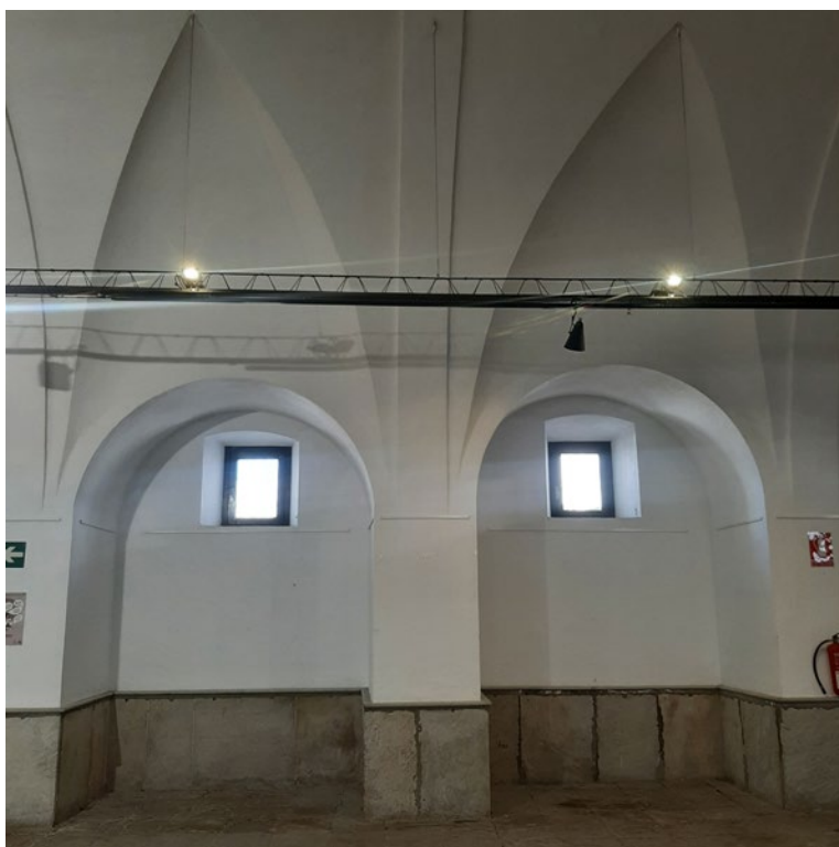
Lámina 7. Contrafuertes laterales e interiores, abovedados y con lunetos, adosados a la amplia bóveda de cañón longitudinal. Fotografía del autor
