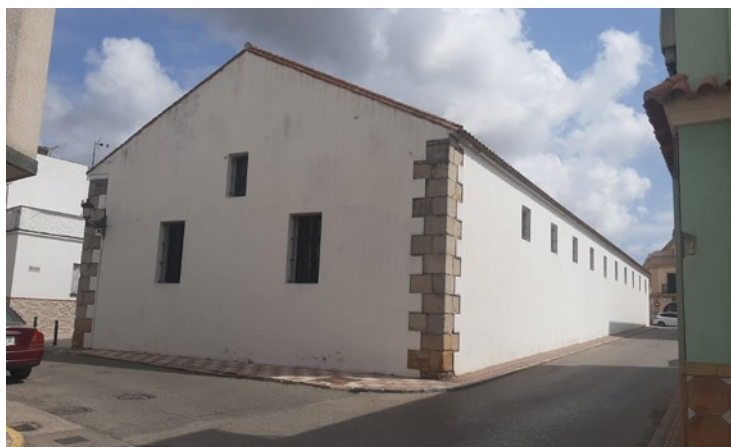
Lámina 2. Fachada posterior de Pósito. Fotografía del autor
