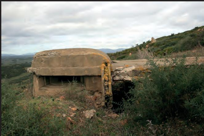
29.- Nido 219a. Se aprecia la cámara de combate a la izquierda, el refugio a la derecha y el murete de protección de su acceso, con aplacado exterior de hormigón y relleno de calicanto
