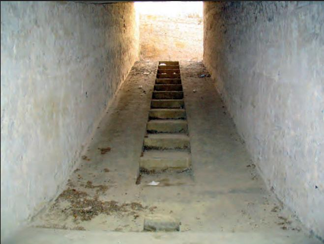
73.- Rampa para el acceso de los cañones anticarro en el búnker 312, con escalones para sus dotaciones. Exteriormente, la rampa continúa descubierta
