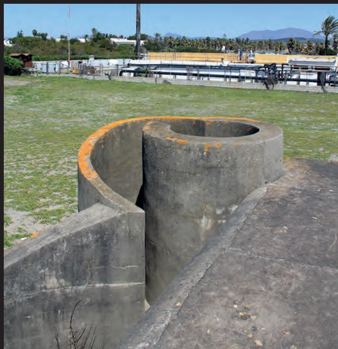
62.- La 33 es una potente obra compuesta, de la misma tipología que la 47. Presenta el pozo de gola con un diseño helicoidal que se encuentra en diferentes elementos del sector oriental del despliegue fortificado
