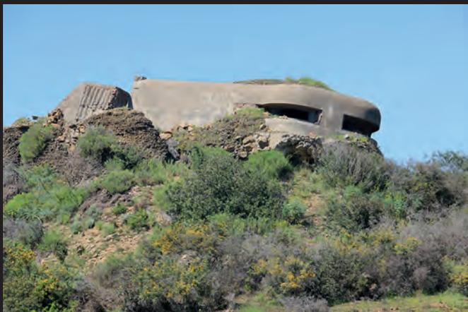
58.- Nido de ametralladoras 61 con pozo de gola sustituido por una galería de fusileros descubierta
