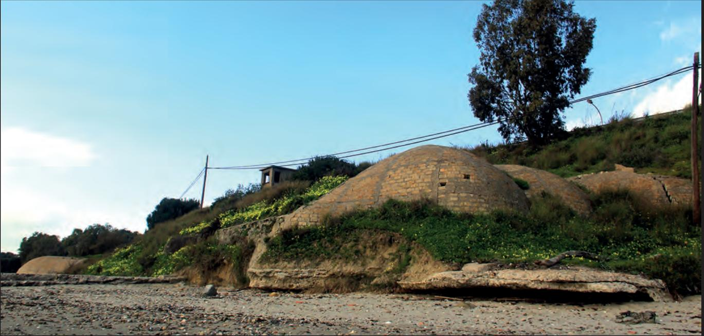
67.- Obra en caverna nº 176, de cubierta reforzada con adoquines. Junto a la siguiente, componen el tipo más complejo de los edificados en este sistema defensivo
