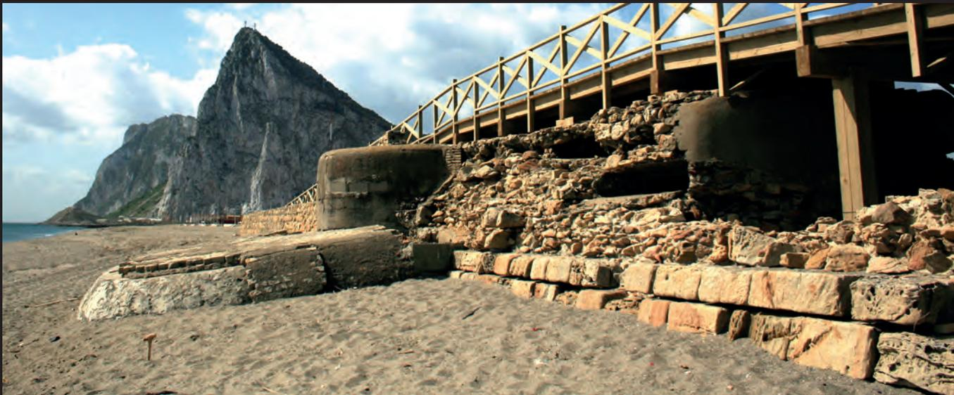
10.- Obra de defensa de flanco en la playa de Levante de La Línea- Es el búnker compuesto 163, con nido de ametralladoras apoyado en la casamata artillera recubierta de adoquines y semienterrada en la arena
