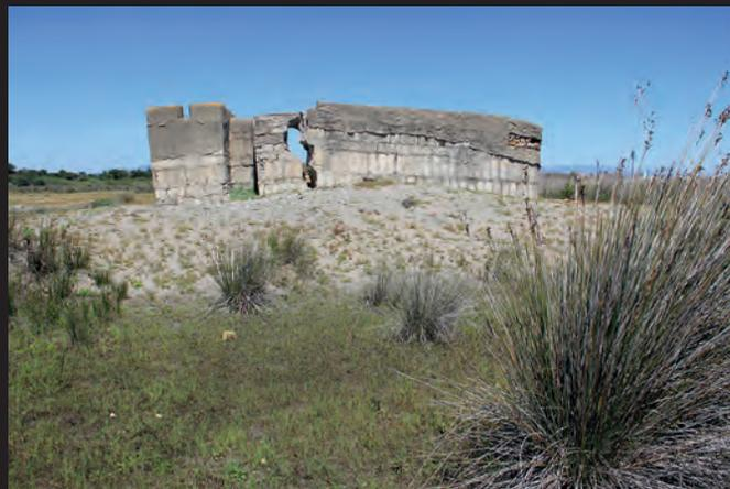
61.- Cimentado en un arenal en ambiente lacustre, el nido 35 ha colapsado por asiento diferencial de la estructura. Se aprecia la fábrica con bloques de hormigón
