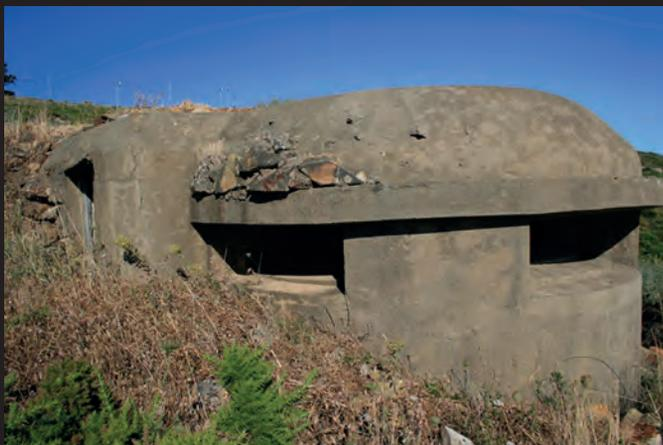
30.- Nido 110. Detalle de los restos del camuflaje pétreo. Puede advertirse el excelente estado de conservación del muro hormigonado
