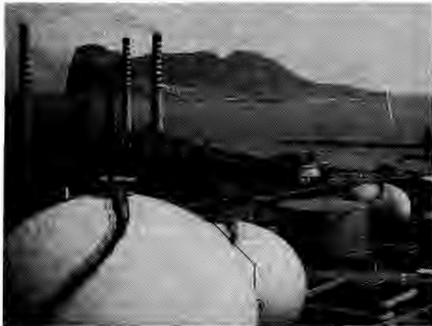
Refinería GIBRALTAR (Vista parcial)
