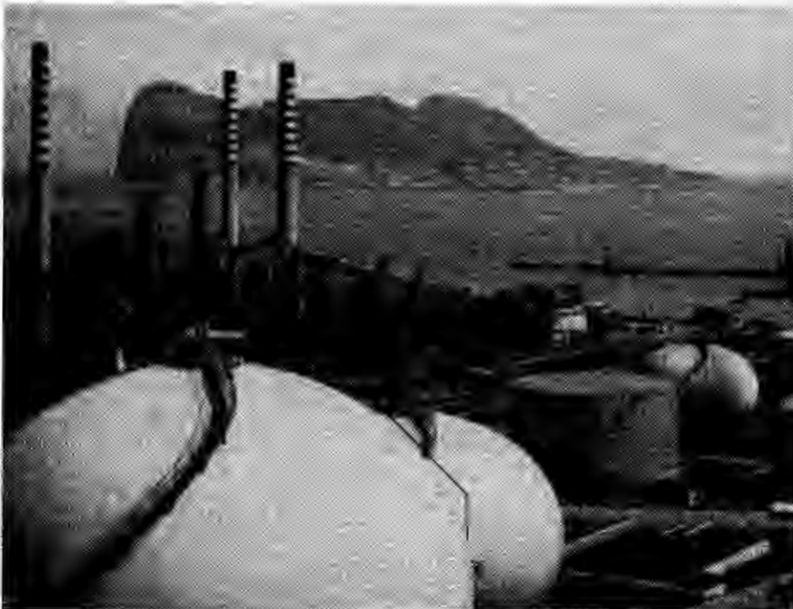
Refinería GIBRALTAR (Vista parcial)
