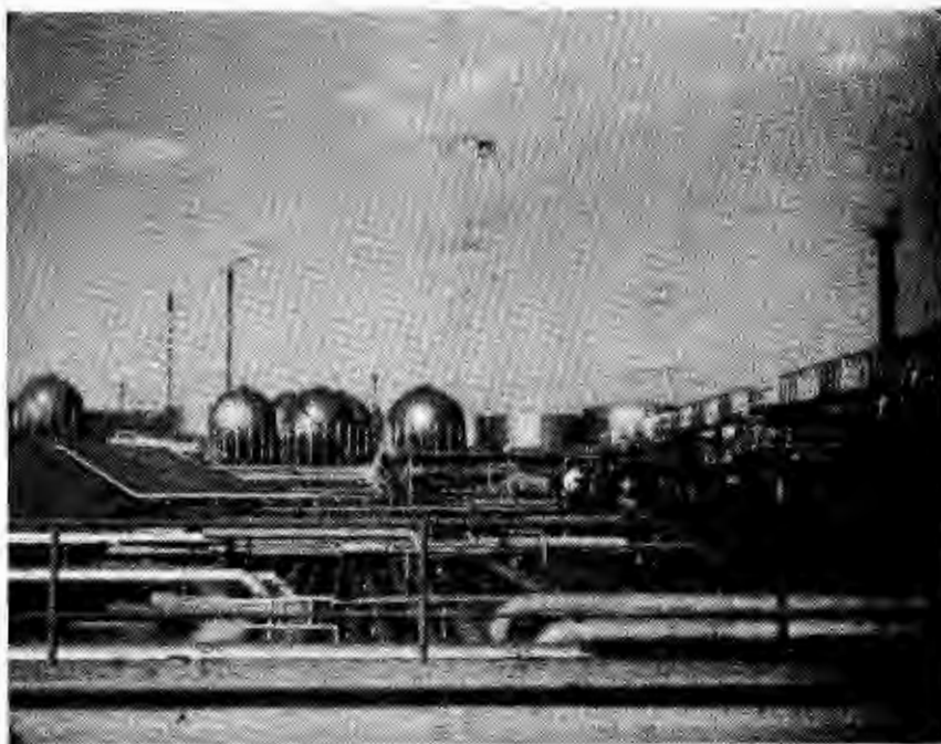
Refinería Gibraltar; vista parcial.
