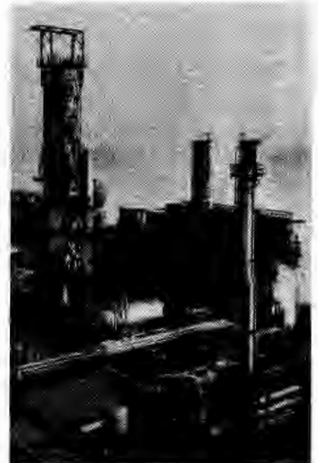
Refinería TENERIFE (Vista parcial)
