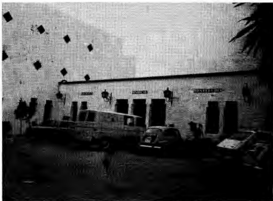
Escuela de Hostelería en San Roque.
