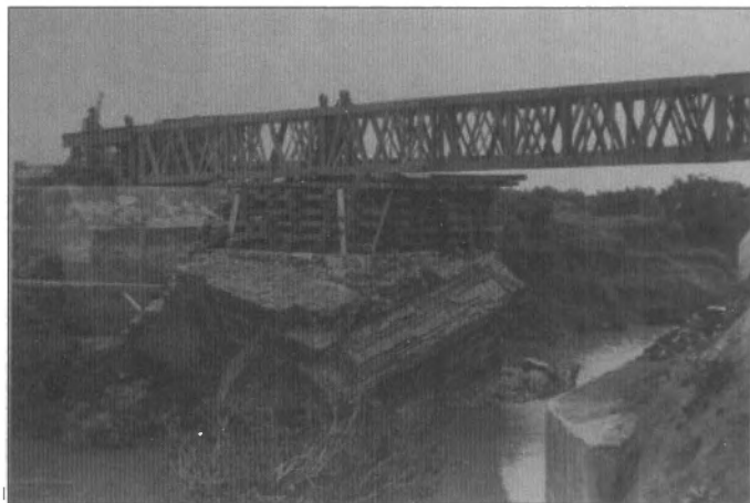
Puente para paso de artillería de 305 y 381 mm.
