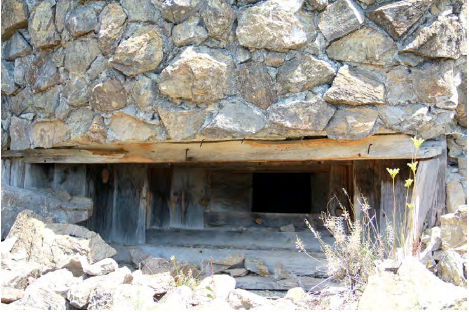
Aspillera escalonada conformada por maderas en la Línea Pirineos (Musser, Lérida). Imagen de A. Sáez
