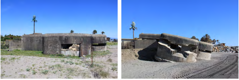
Casamata 33 (para cañones y ametralladoras) a orillas del Mediterráneo (Guadalquítón, San Roque), en fotografías de 2013 (izq.) y 2023 (dcha). La pérdida del sustrato arenoso, en un proceso perfectamente previsible, ha causado su colapso. Imágenes de A. Sáez
