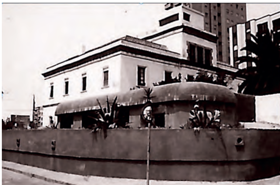
Bunker 152b situado junto a la antigua Comandancia Militar de La Línea, que fue visitado por las comisiones alemanas que prepararon la Operación Félix. Demolido a mediados de los noventa, a pesar de las protestas de los estudiosos del tema
