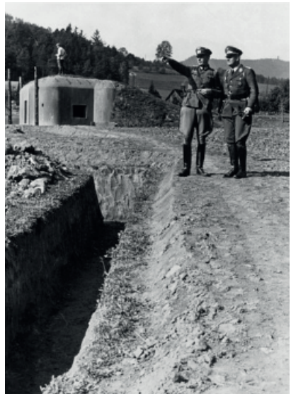
Inspección a las obras de la Línea Sigfrido, un conjunto que el teniente coronel López Tienda tuvo la oportunidad de visitar antes de incorporarse a la Comisión Jevenois
