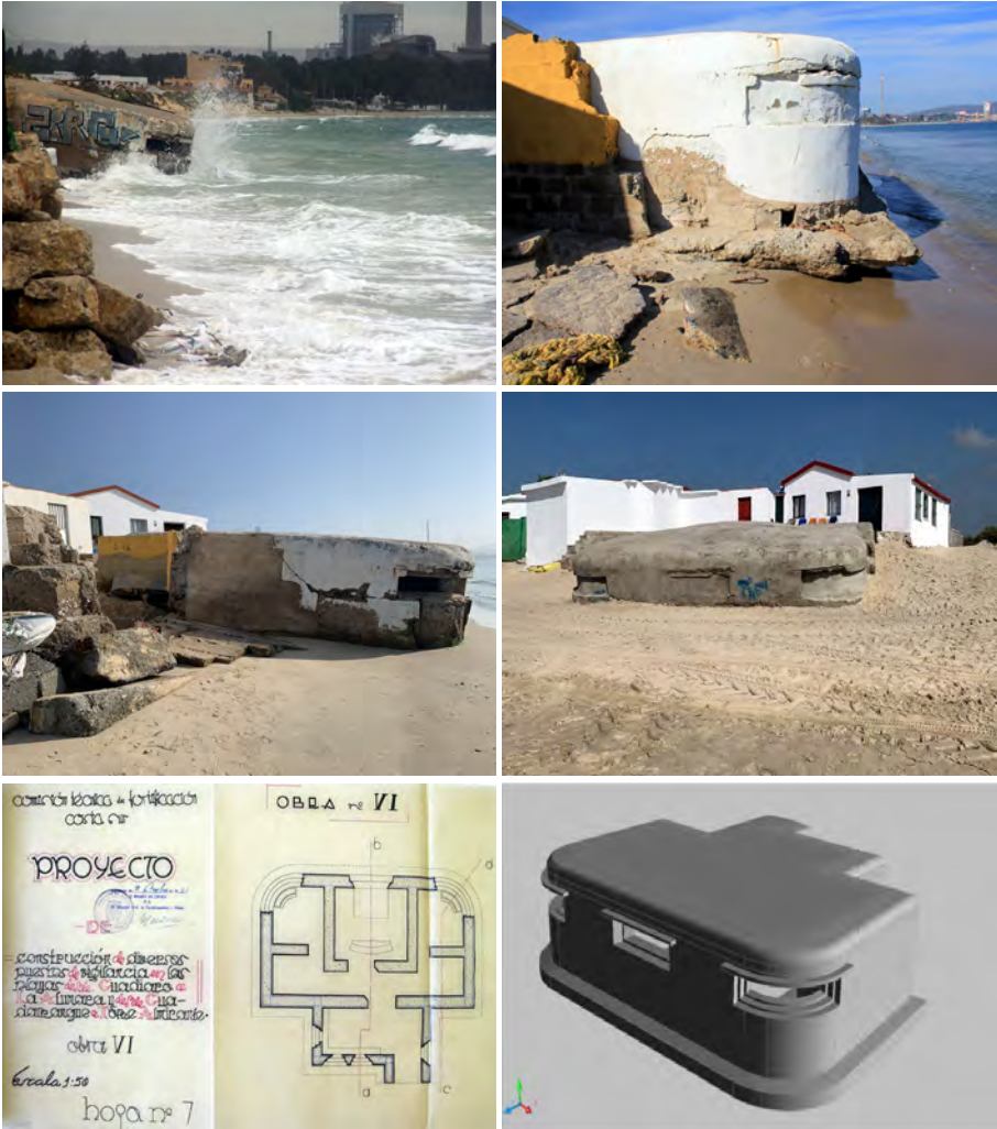
Casamata 263 de El Rinconcillo (Algeciras). Su exposición al oleaje en la primera línea de playa (foto 1) provocó su descalce (foto 2-2017). En 2020 estaba agrietado y amenazaba ruina total (foto 3), siendo restaurado en abril de 2021 por la APBA (foto 4). Fotografías de A. Sáez. La obra fue diseñada en 1943 (imagen 5, Archivo Intermedio de Sevilla), mostrándose su reconstrucción ideal (imagen 6, Salvador García Villalobos. Yamur, S.L.)
