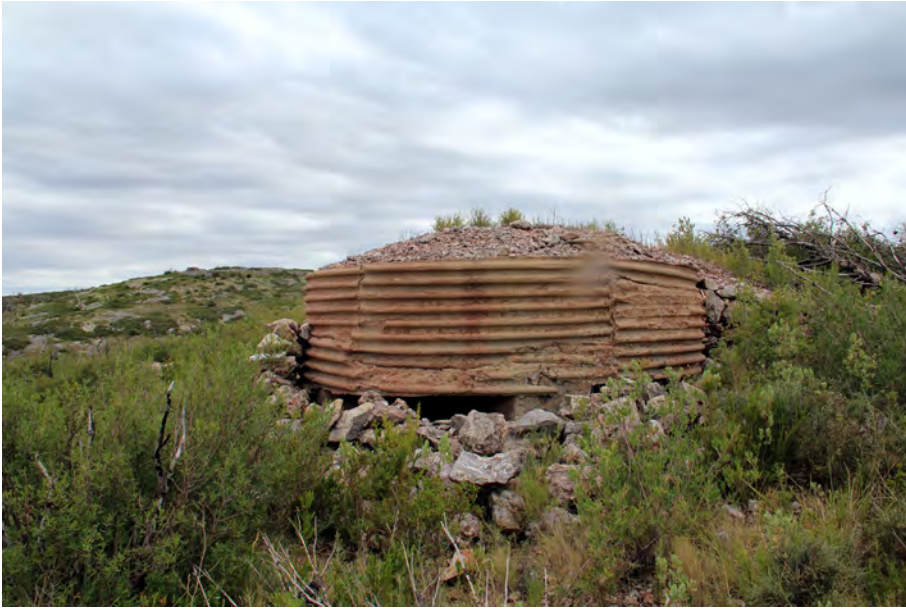
Nido conformado con encofrado de chapa metálica en la Línea Pirineos, logrando este peculiar acabado (Biure, Alto Ampurdán, Gerona). Imagen de A. Sáez
