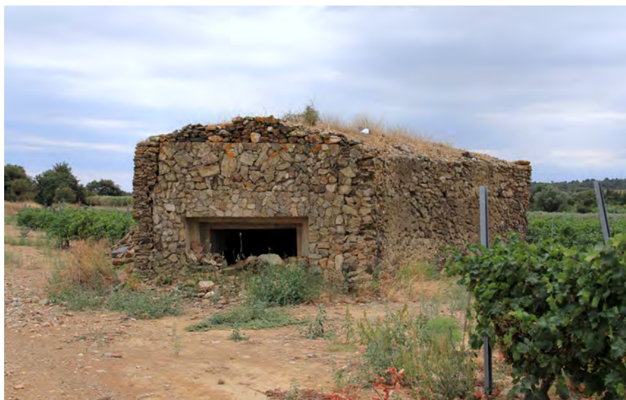
Posición de artillería de la Línea Pirineos en Garriguella (Gerona), camuflada como vivienda, según resulta habitual en esta zona vinícola. Imagen de A. Sáez
