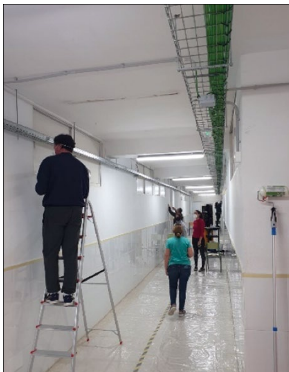
Lámina 2. Pintura de pasillos del edificio principal donde se situarían las infografías. Imagen de M a Inmaculada Gamero Bejines
