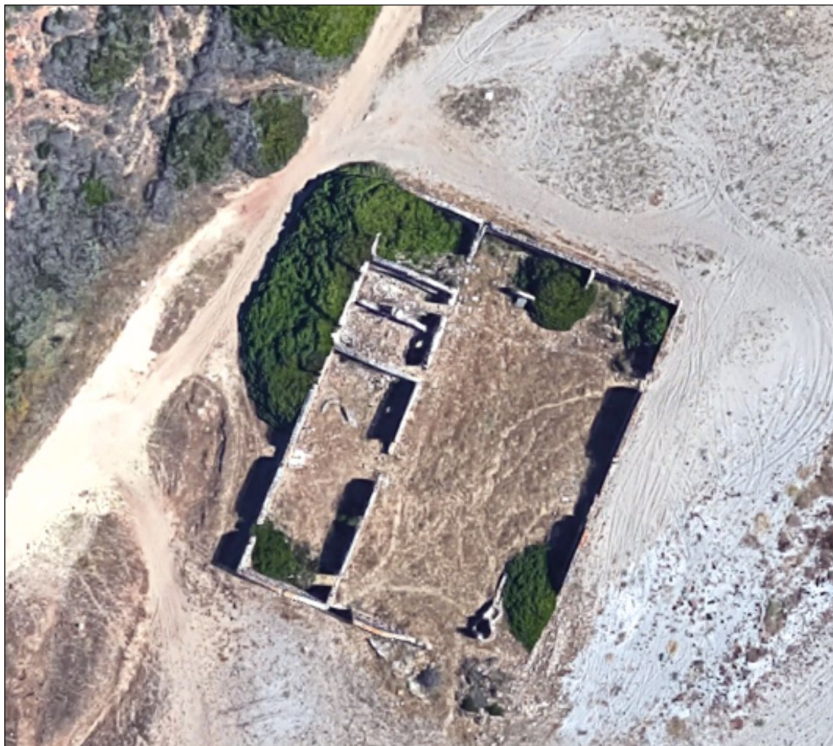
Lámina 2. Foto área de la edificación existente, conocida como edificio de La Almadraba o de La Tabacalera, hasta el 29 de noviembre de 2022. Imagen de Google Maps
