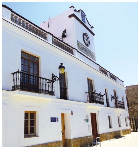
Lámina 7. Fachada de las Casas Consistoriales en la plaza de Santa María. Foto: autor
