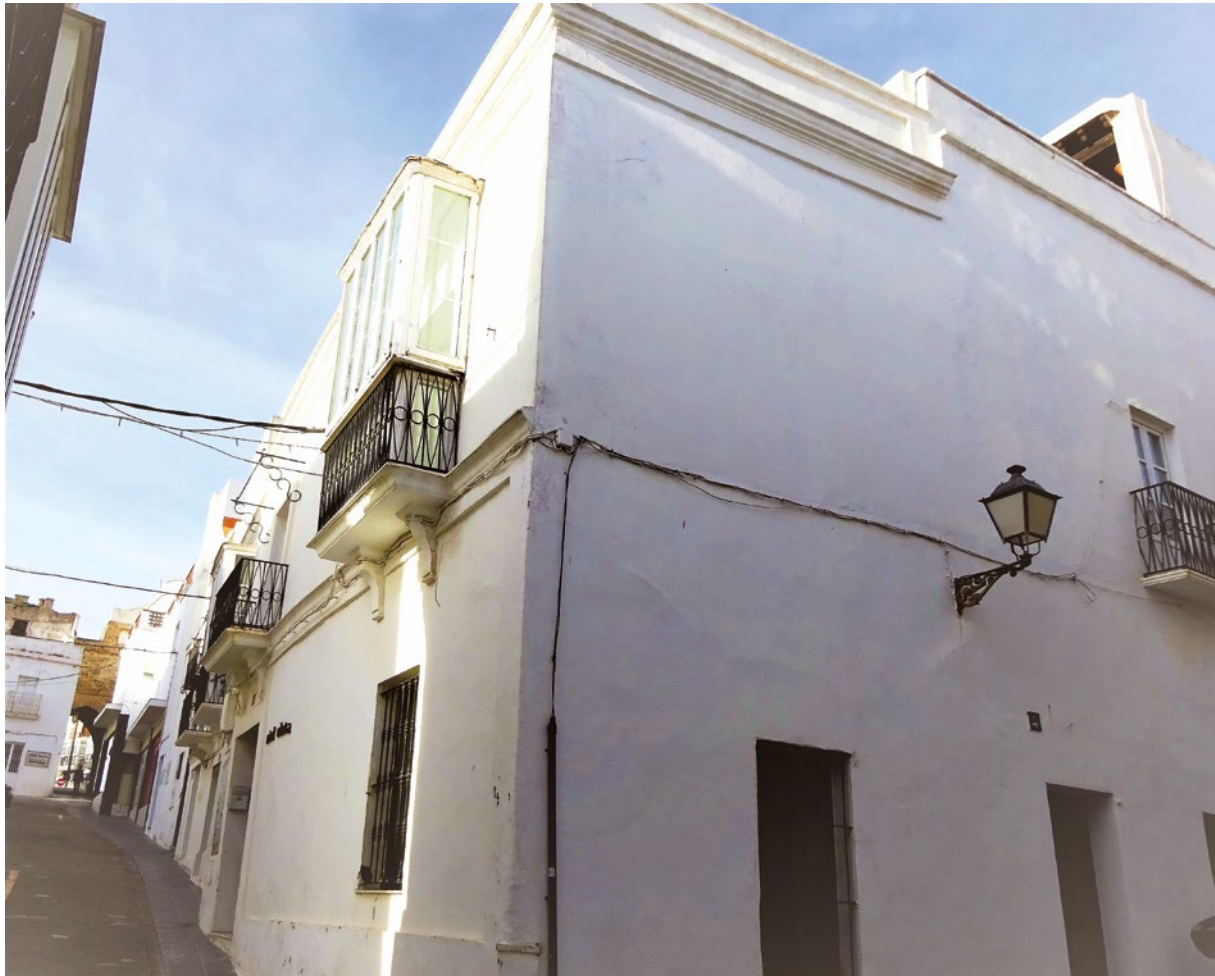
Lámina 5. En esta mansión en la calle Jerez esquina con General Vives estuvo el Consistorio entre 1862 y 1884. Al fondo, la emblemática Puerta de Jerez. Foto: autor
