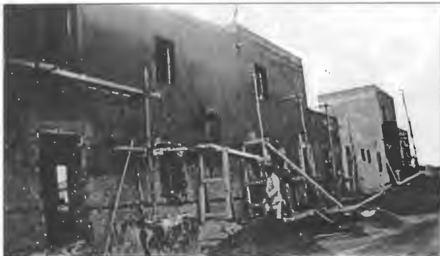
Figura 6. Construcción de la calle Tapatana (1950). Fotografía cedida por D. Lorenzo Gamó.
