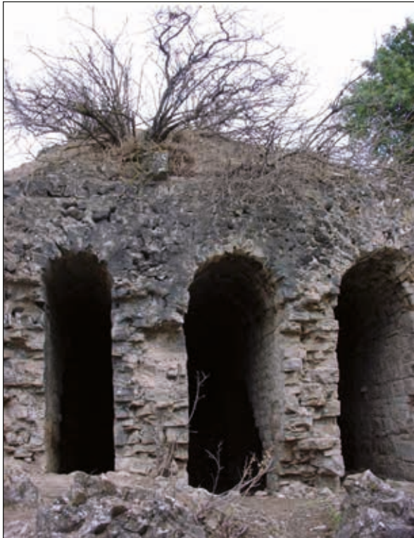
Lámina 9. Detalle del criptopórtico de Jimena. Imagen de Salvador Bravo
