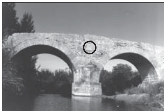
Figura 2. Puente de la Madre Vieja por el lado que mira al mediodía y antes de su reciente restauración. Obsérvese el escudo de piedra labrada sobre el machón del puente. Fotografía de Juan Antonio García Rojas.
