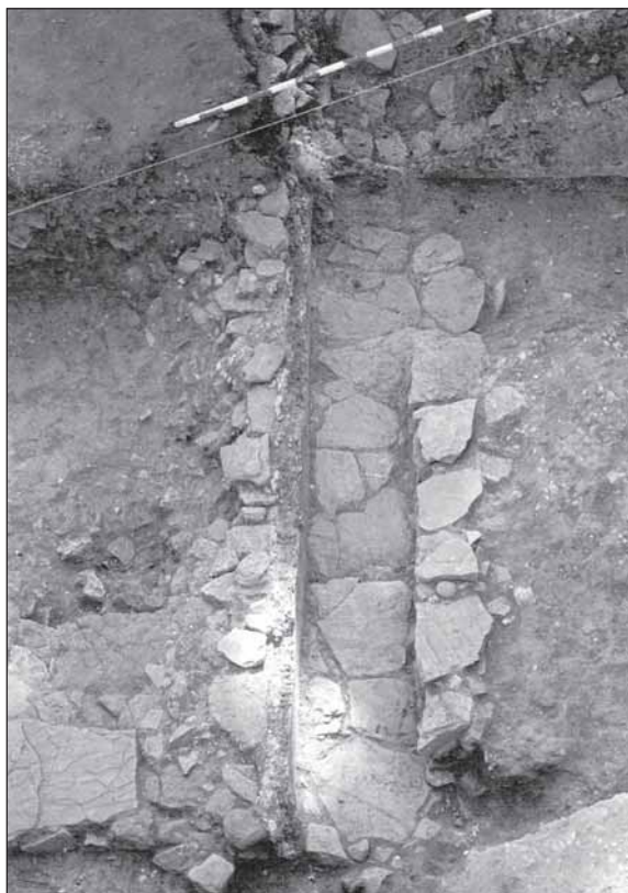
Figura 3. Detalle de la Canalización I, de época bizantina.
