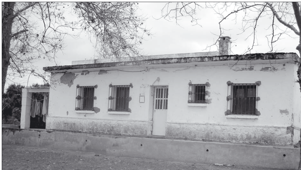
Figura 2. Fachada de una antigua escuela.
