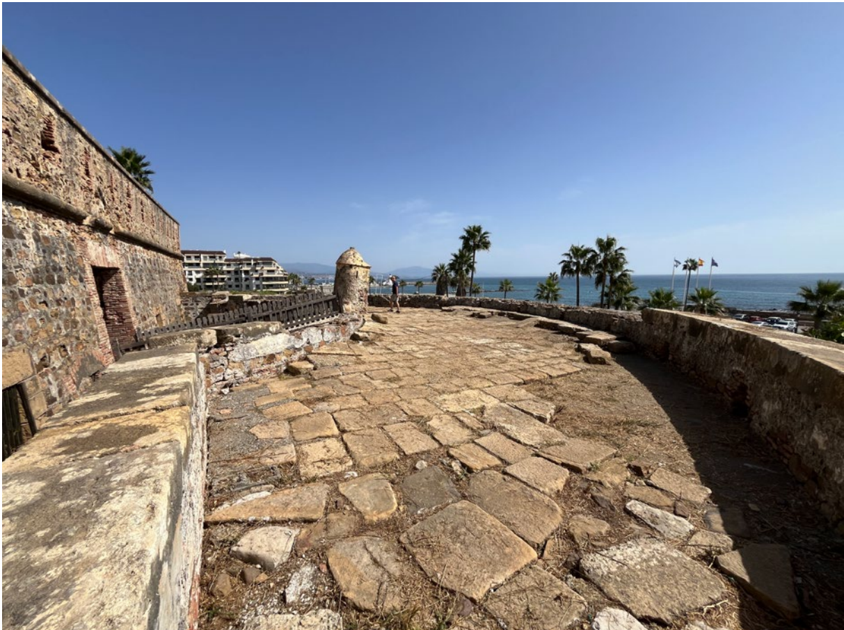
Lámina 10. Panorámica que muestra el hundimiento de la plataforma artillera, causando la inclinación de la garita. Imagen de P. Gurriarán
