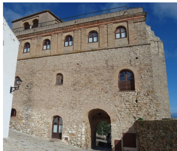
Lámina 6.- Estado actual del edificio que, en 1813, era la casa-palacio del Marqués de Moscoso que en la actualidad es un establecimiento hotelero. Fotografía del autor
