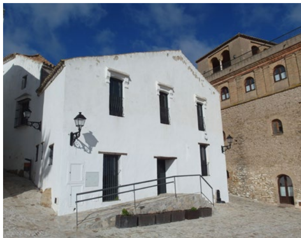
Lámina 5.- Estado actual del edificio delósito en tiempo de la memoria de Blas Manuel Teruel, que después fue la sede del ayuntamiento de Castellar de la Frontera antes de su traslado, en 1971, a la sede del nuevo edificio en Castellar Nuevo. Fotografía del autor
