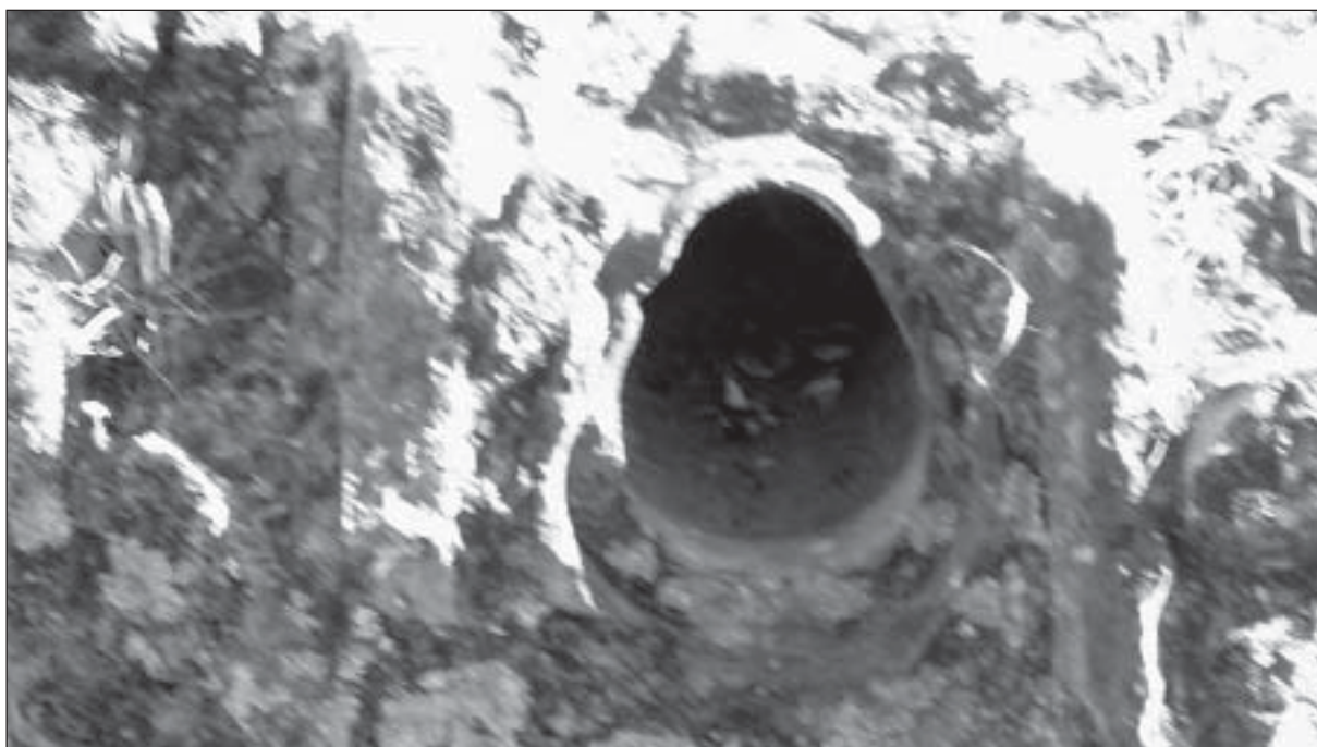
Ilustración 5. Vista de un corte del muro de canal con la tubería de agua potable incluida en la obra.
