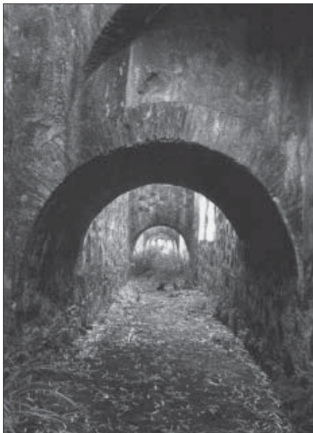
Ilustración 1. Interior del Canal de la Real Fábrica del Hozgarganta, donde se puede apreciar la solidez de los contrafuertes.
