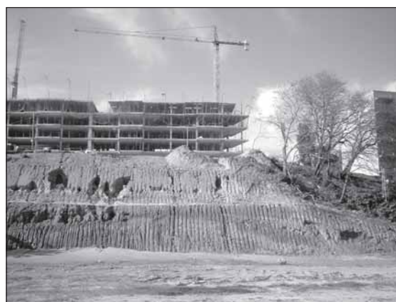
Ilustración 13. Aspectos de la erosión pluvial en el terreno del yacimiento, desprotegido tras la destrucción de la histórica batería.
