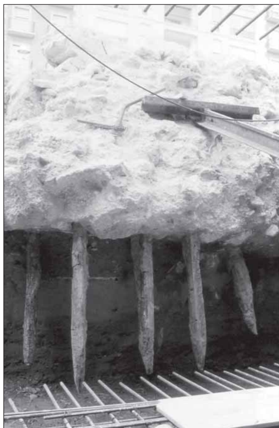
Lámina 3. Detalle del sistema de cimentación con pilotes de madera del castillo de los Genoveses de Málaga (S. XV) (Fotografía cedida por M. Ación Almansa).
