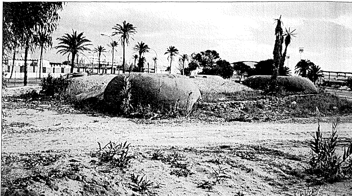
Figura 4. Bunker 162 a mediados de los noventa. Hoy es una galería de exposiciones.
