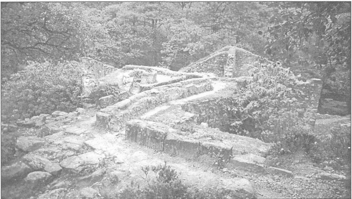
Figura 14. Cao del molino del Águila, en progresivo estado de deterioro por el comportamiento vandálico de algunos de sus visitantes, ya que la zona carece de cualquier tipo de vigilancia.
