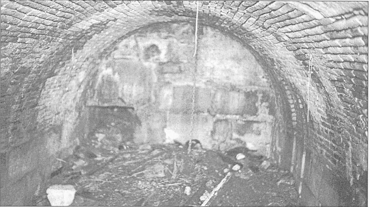
Figura 6. La bóveda mejor labrada de los molinos del río de la Miel es la de El Cobre, con fábrica de ladrillo generada por un arco de medio punto de perfecta sillería de piedra arenisca.
