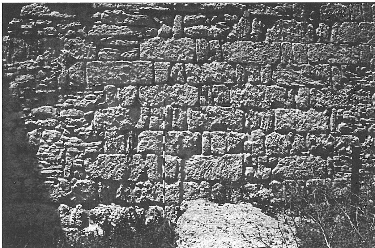
Lámina 2. Aparejo califal de sogá y tizón. Vista parcial de la zona central del lienzo H.
