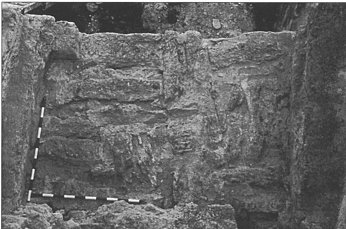
Lámina 3. Vista cenital del lienzo H. Se aprecia el empleo de sillares cuidadosamente trabajados y aparejados como relleno de las estructuras.
