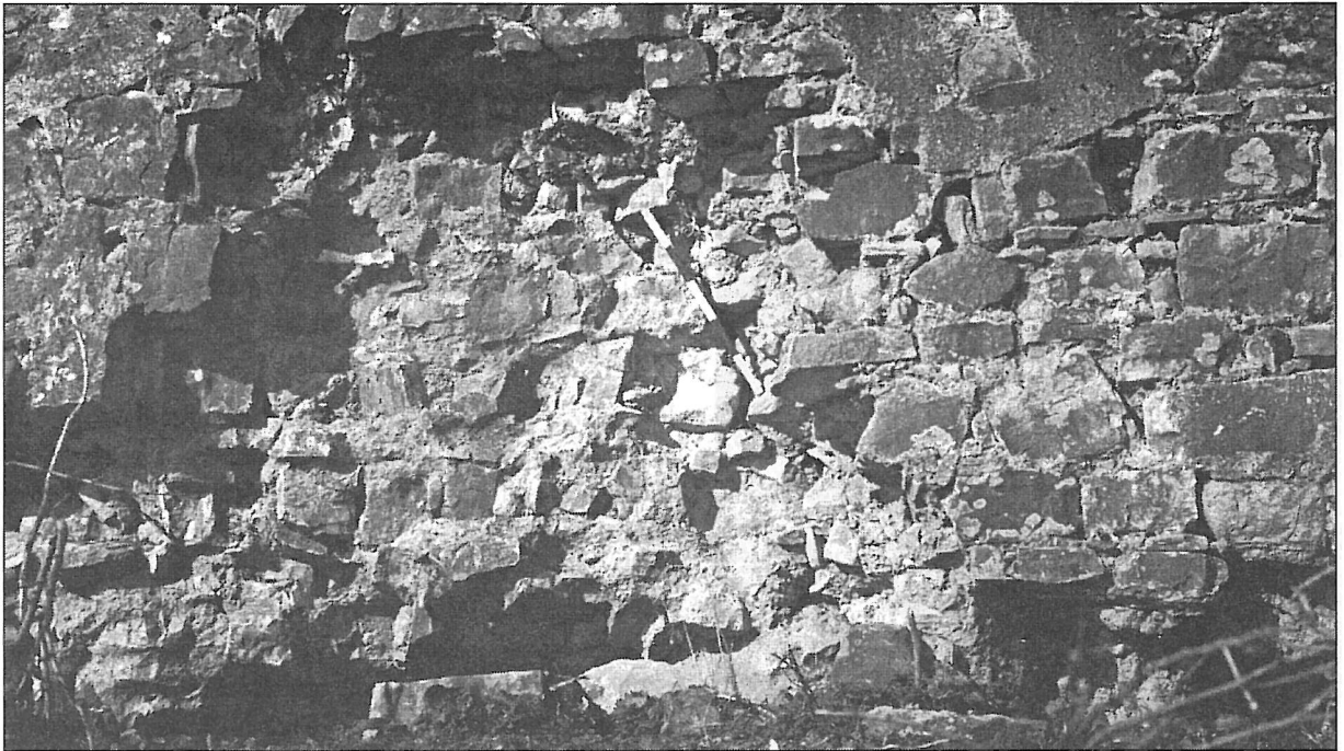
Figura 4. El antemuro al sureste del castillo, mostrando la unión entre dos tramos de distinta edad: a la izquierda el tramo de 14 metros de fecha desconocida, y a la derecha el muro islámico.
