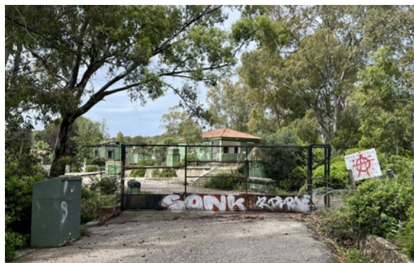
Lámina 2. Entrada al recinto, vandalizada, como todo el conjunto. Imagen de A. Sáez, 2024
