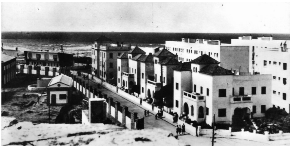
Lámina 13. Camino de la Isla, Tarifa. A la derecha, las edificaciones militares finalmente construidas en el emplazamiento reservado para las 25 viviendas protegidas. Fotografía de los años 50 del pasado siglo. Colección del autor
