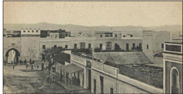
Lámina 5. Entorno urbano en el que se ubicaba el solar destinado al bloque de 24 viviendas protegidas de Alberto Balbontín, eje del ensanche extramuros de Tarifa según la carretera Cádiz-Málaga, calle Batalla del Salado. Fotografía del primer tercio del siglo pasado. Colección del autor
