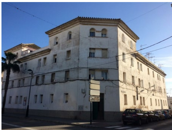
Lámina 8. Pabellones militares, Tarifa, conjunto residencial construido en el solar del emplazamiento de las 24 viviendas protegidas de Alberto Balbontín. Fotografía actual. Colección del autor
