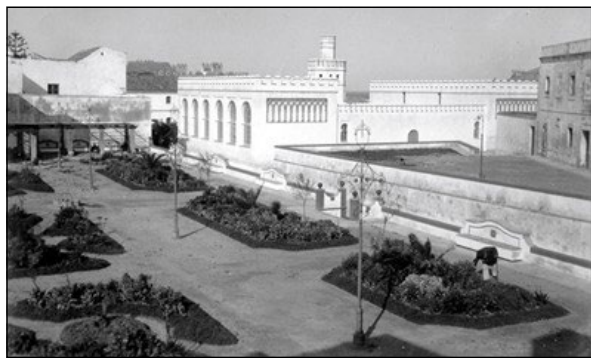
Lámina 1. A la derecha, en alto respecto a los jardines del Miramar, y en cuña, el solar previsto para la construcción del bloque de 12 viviendas protegidas de Alberto Balbontín. Entre el solar y los jardines, a cota inferior, discurría la calle Amargura, que los separaba. Fotografía de los años 30 del pasado siglo. Colección del autor
