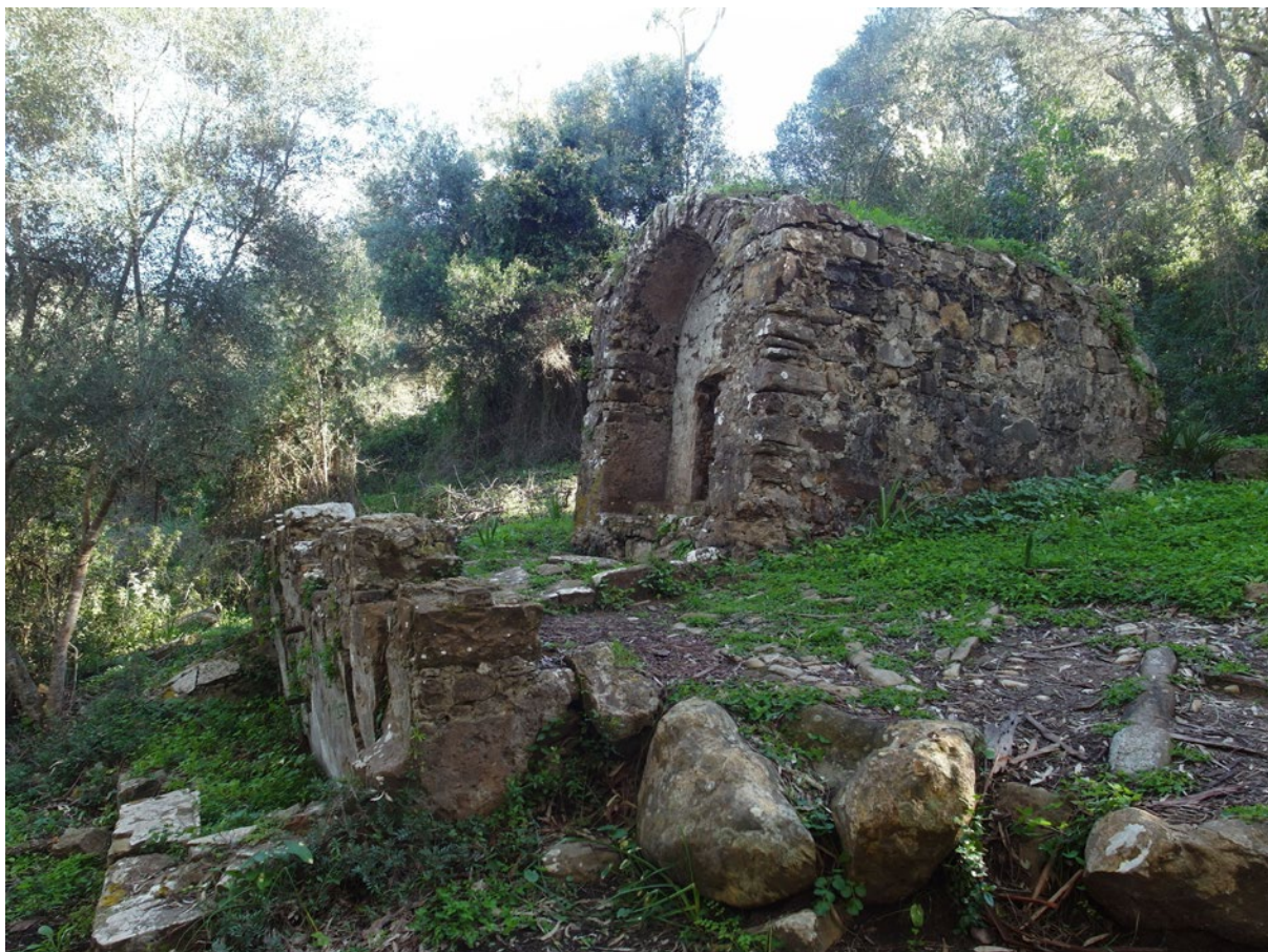
Lámina 8.- Estado actual de la Fuente Vieja del castillo de Castellar de la Frontera, principal punto de abastecimiento hídrico de la población a principios del XIX. Una muy interesante edificación en la que urge una restauración. Fotografía del autor
