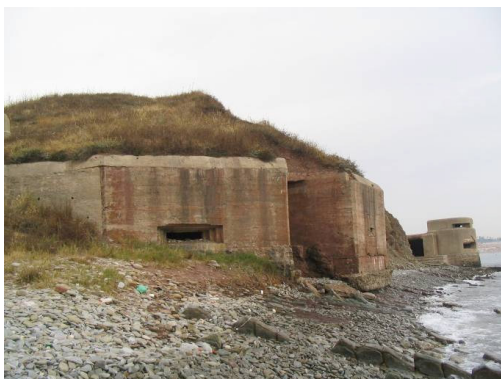
Lámina 38. Elemento 323c. Obra en caverna ejecutada con hormigón fino con árido del lugar, playa de Getares, Algeciras.
