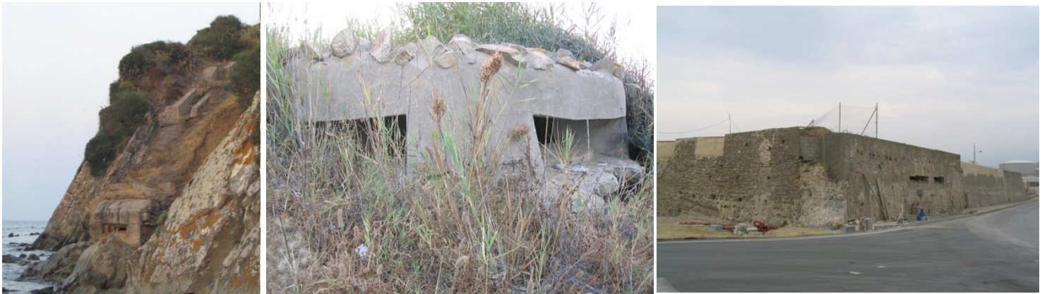
Lámina 16. Obra en Punta Carnero, Algeciras. No mimética en la que se acude al propio material constructivo, hormigón con árido de la zona, y a la topografía del terreno para conseguir un más que aceptable camuflaje.
