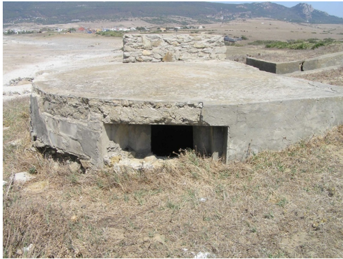
Lámina 32. Nido con cubierta simple hormigonada, Bolonia, Tarifa.
