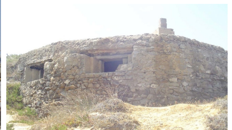
Lámina 38. Elemento 323c. Obra en caverna ejecutada con hormigón fino con árido del lugar, playa de Getares, Algeciras.
