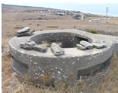
Lámina 26. Pozo de gola en Bolonia, Tarifa. Caso habitual de replanteo circular. Lámina 27. Nido de ametralladoras en La Mencha Algeciras. Clásico replanteo semicircular peraltado. Lámina 28. Casamata artillera en el Istmo de La Línea, de replanteo rectangular.
