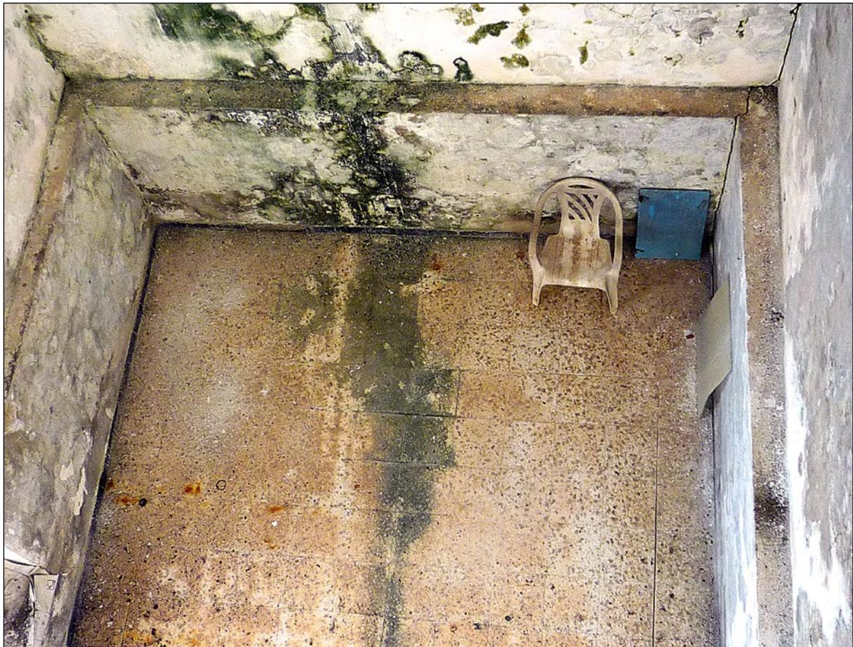
Lámina 8. Interior de la torre donde se observan las repisas que, posiblemente, coinciden con el emplazamiento de los forjados de madera de los pisos. © Los autores
