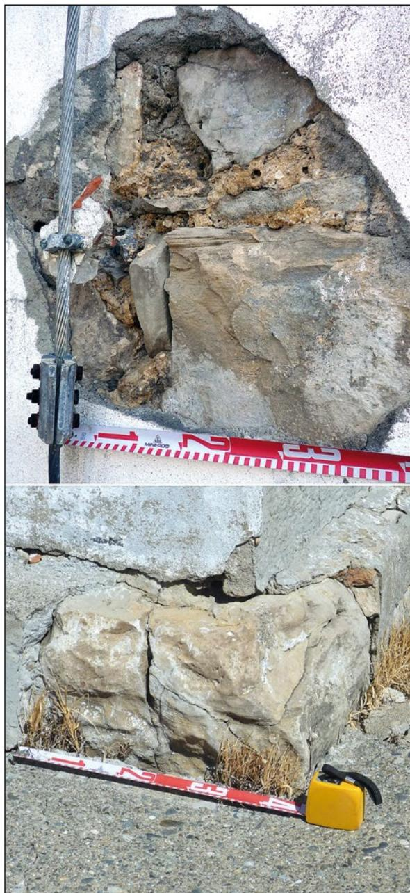
Lámina 7. Fábrica de mampostería de la torre en la fachada noroeste (arriba). Zócalo con sillarejos en la esquina sur (abajo). © Los autores
