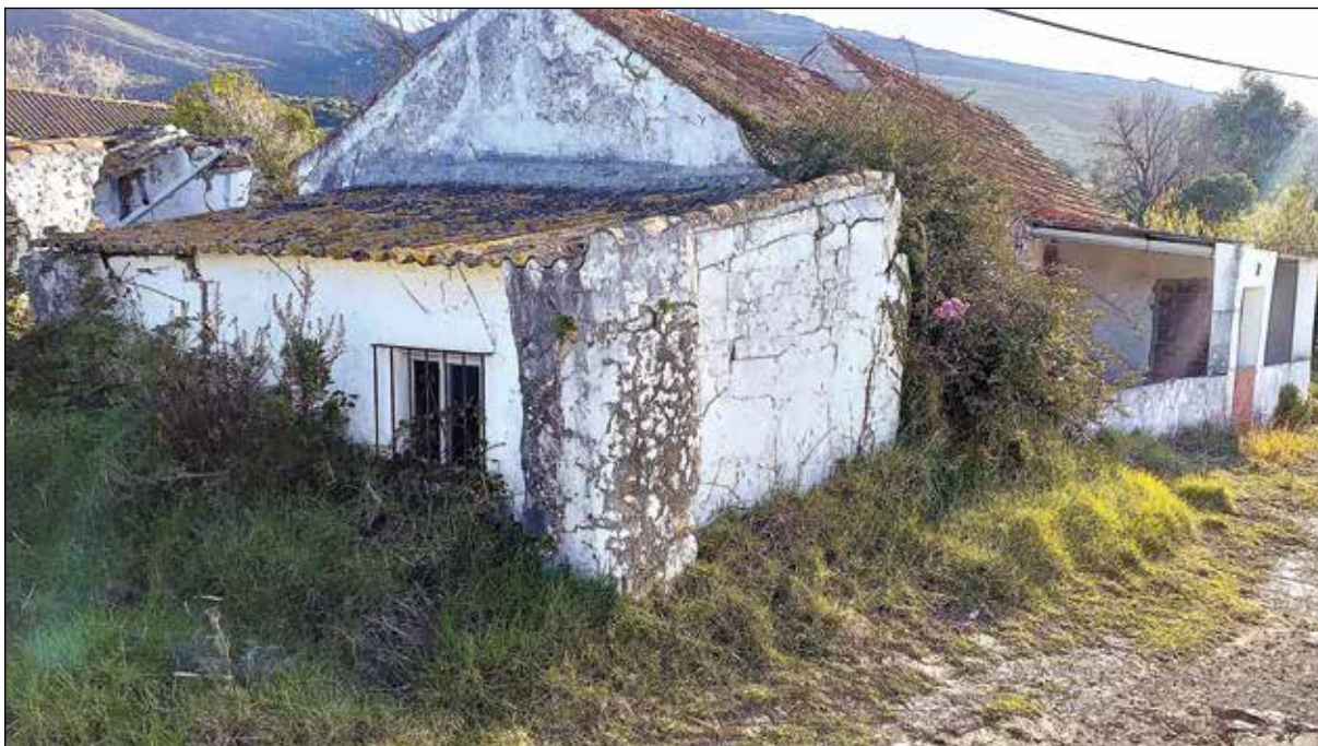
Lámina 8a. Esta casa semi arruinada junto a la carretera en Casas de Porro tiene restos de gruesos muros, inusuales para una pequeña vivienda como la actual. Fotografía del autor
