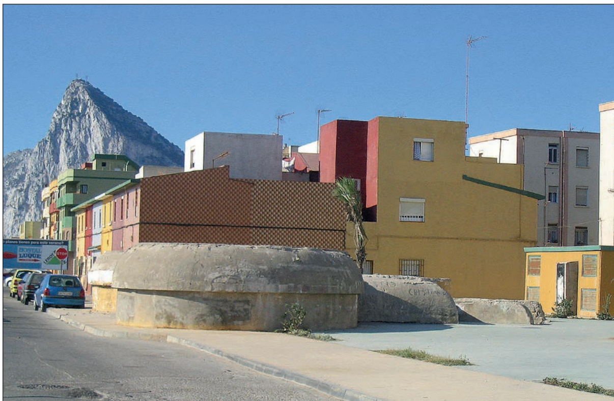
Lámina 7. El nido múltiple de ametralladoras número 148, en 2004, situado en La Atunara (La Línea de la Concepción). Tenía las aspilleras cegadas para evitar el vertido de basuras y se conservaba en correcto estado. Fotografía de A. Sáez
