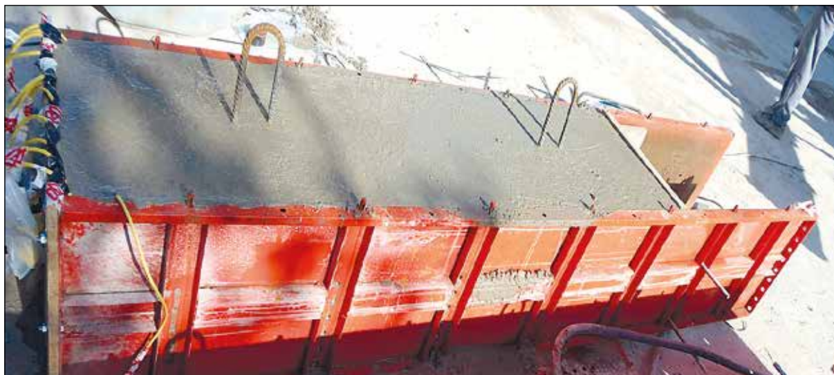
Lámina 8. Fraguado del bartolo. Imagen de los autores
