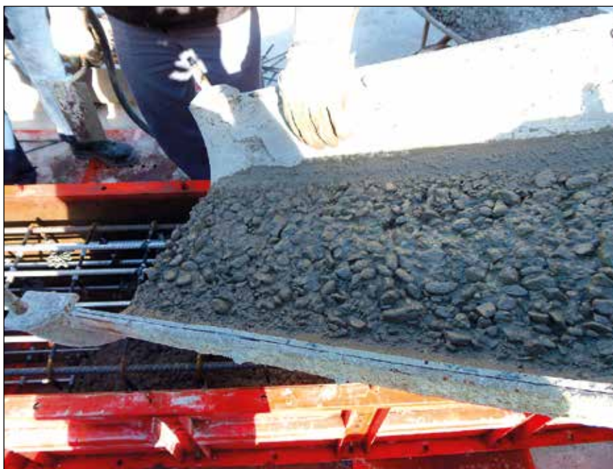
Lámina 7. Hormigonado del bartolo. Imagen de los autores
