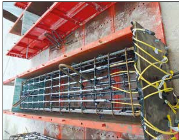
Lámina 6. Estructura en el molde. Imagen de los autores
