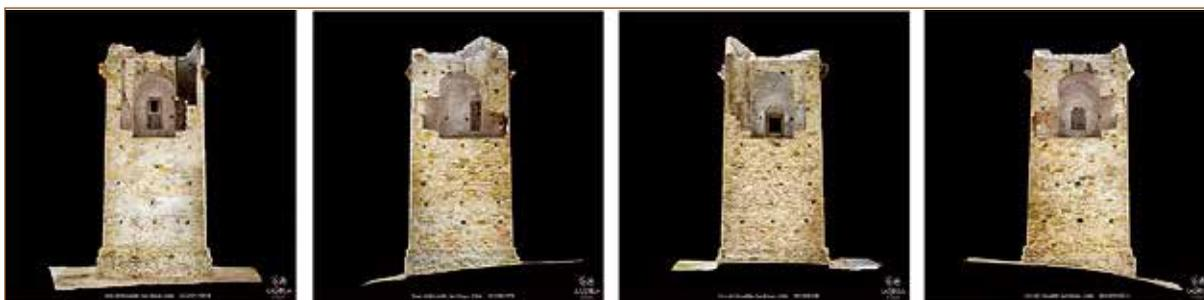
Lámina 21. De izquierda a derecha, estado actual de la torre del Rocabllo; restitución material y restitución final mediante software 3D. Imagen de La Sibila S.L.
