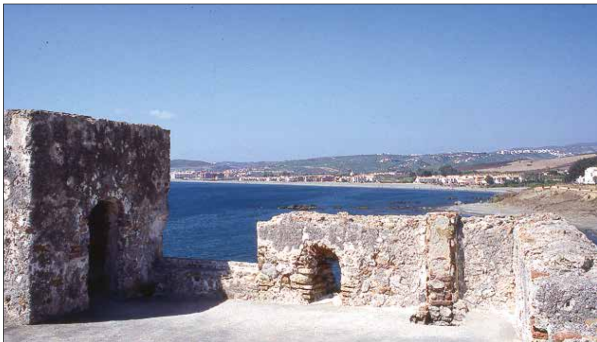
Lámina 7. Terrado del edificio en 1998 con chimenea, aspillera y garita para el desembarco de la escalera. Imagen de A. Sáez
