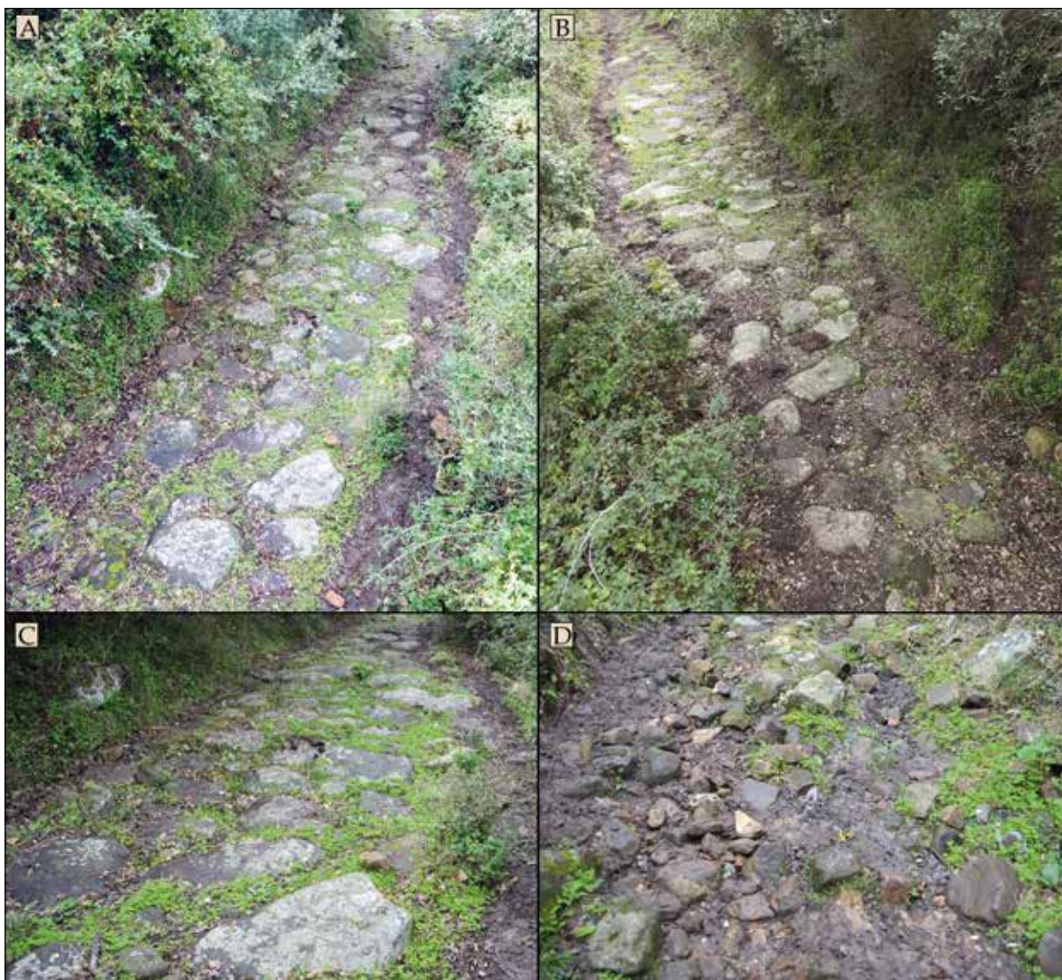
Lámina 3. Vistas aéreas del camino empedrado: zona baja (A), zona superior (B), detalle de los mampuestos (C) y zona desmochada del camino en el extremo superior, donde se aprecia su posible preparación (D)
