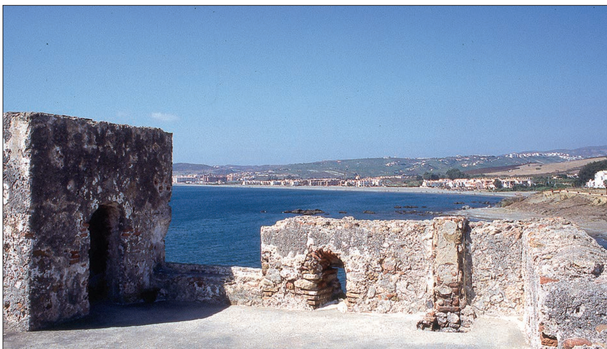
Lámina 7. Terrado del edificio en 1998 con chimenea, aspillera y garita para el desembarco de la escalera. Imagen de A. Sáez
