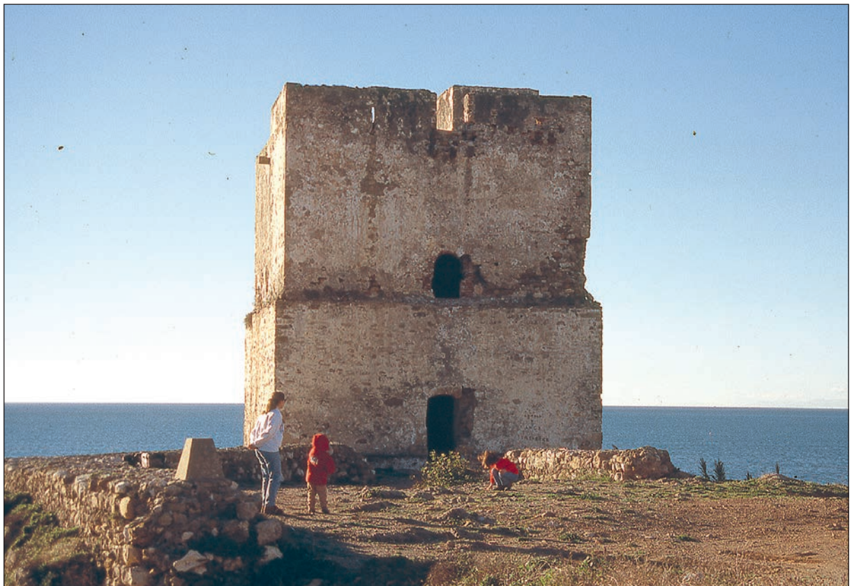
Lámina 5. Fachada norte en 1998. Imagen de A. Sáez
