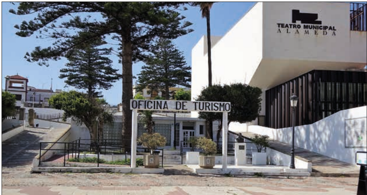
Lámina 6. Rampas de acceso desde la Alameda a la primera plaza. Imagen del autor
