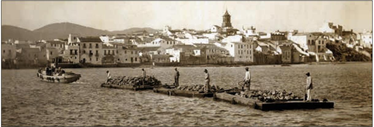
Lámina 9. El Ojo del Muelle señalado con asterisco en "Chalanas transportando escollera para las obras del muelle de la Galera". Año 1917. Archivo fotográfico de la APBA
