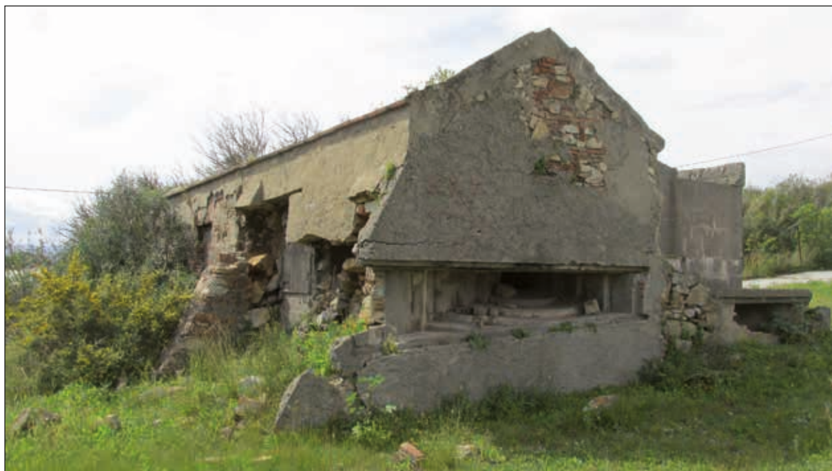
Lámina 2. Nido 140 camuflado en vivienda rural en la Travesía Norte de La Línea de la Concepción. Imagen de José M a Moreno
