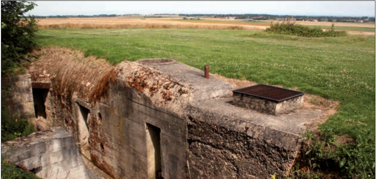
Lámina 10. Posición fortificada Hillman en Colleville-Montgomery, Normandía (Muralla del Atlántico, Francia). 2014. El búnker es invisible, salvo que el observador aéreo reconozca la estructura de acceso al complejo subterráneo. Imagen de Ángel Sáez
