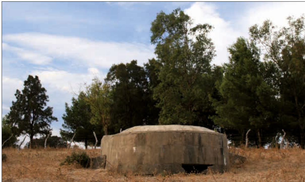
Lámina 8. Fortín observatorio 225 del Cortijo de Torres (San Roque) en 2009. Dispone de muretes de piedra en los flancos para desdibujar la silueta de la construcción y permitir el desarrollo de plantas silvestres. Imagen de Ángel Sáez
