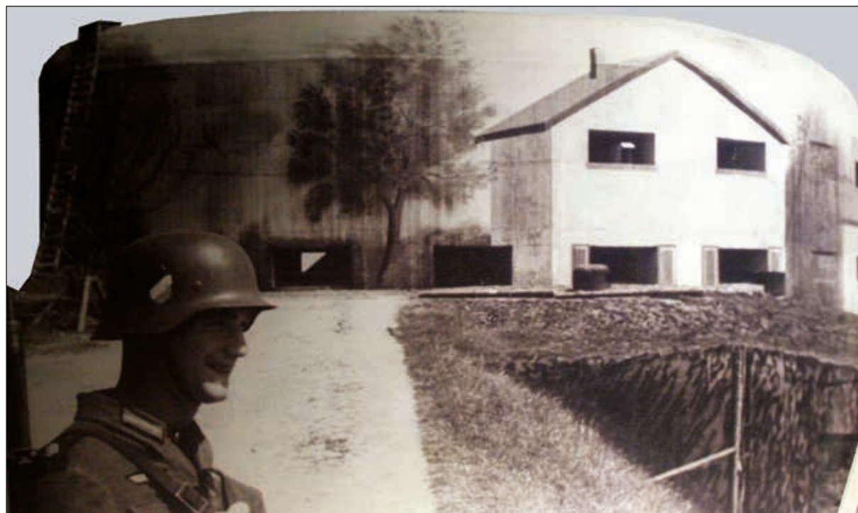
Lámina 5. Mimetización de una casamata Todt bajo la representación de una casa. 1944. Las cuatro casamatas de la Batería Todt se localizan en el Cabo Gris-Nez (Paso de Calais, Francia). Archivo de Ángel Sáez
