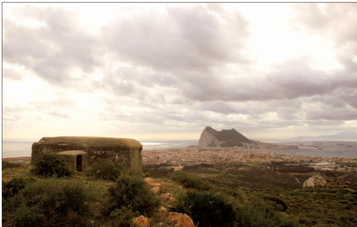
Lámina 7. Fortín observatorio 107 de Sierra Carbonera (San Roque) en 2010. Se aprecia su parte trasera, con la galería de acceso. Dada su posición tan expuesta, cuenta con un techo de hormigón armado de 200 cm de espesor. Imagen de Ángel Sáez
