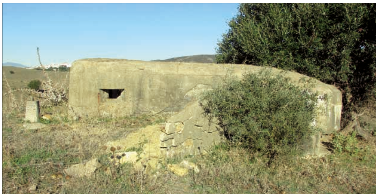
Lámina 9. Fortín observatorio 227, cercano al anterior y con la misma solución constructiva para facilitar su mimetismo en el terreno circundante. Imagen de Ángel Sáez
