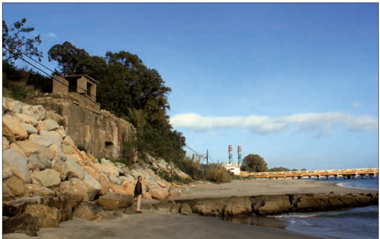
Lámina 14. El mismo fortín 175b/Obra V en 2017, con la escollera aplicada para estabilizar el talud de la carretera. Imagen de Ángel Sáez
