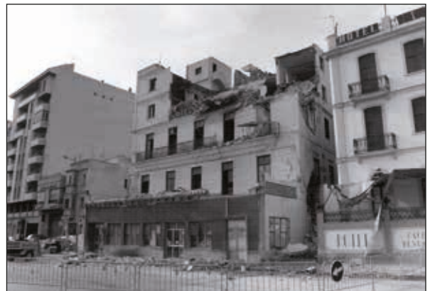
Lámina 20. Demolición del hotel Término. Fotografía subida al grupo de Facebook "Historia de Algeciras en imágenes" por José Adrada
