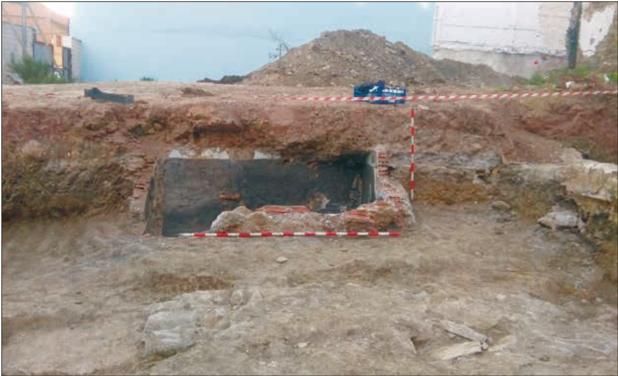
Lámina 10. Estructura de la última fase constructiva del hotel Término. Imagen de Salvador Bravo
