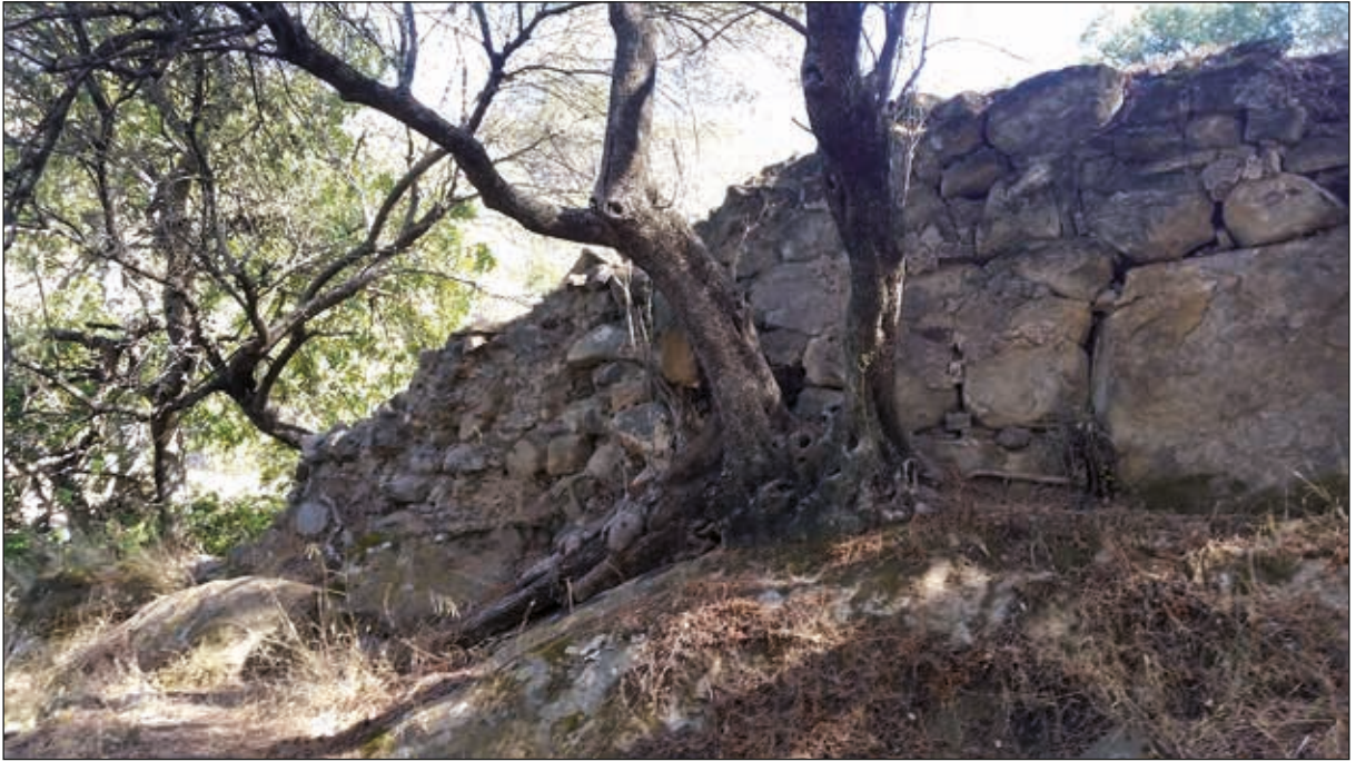
Lámina 2. Vestigios del amurallamiento más desconocido del castillo de Jimena, al pie de su ladera oeste. Fotografía de A. Sáez
