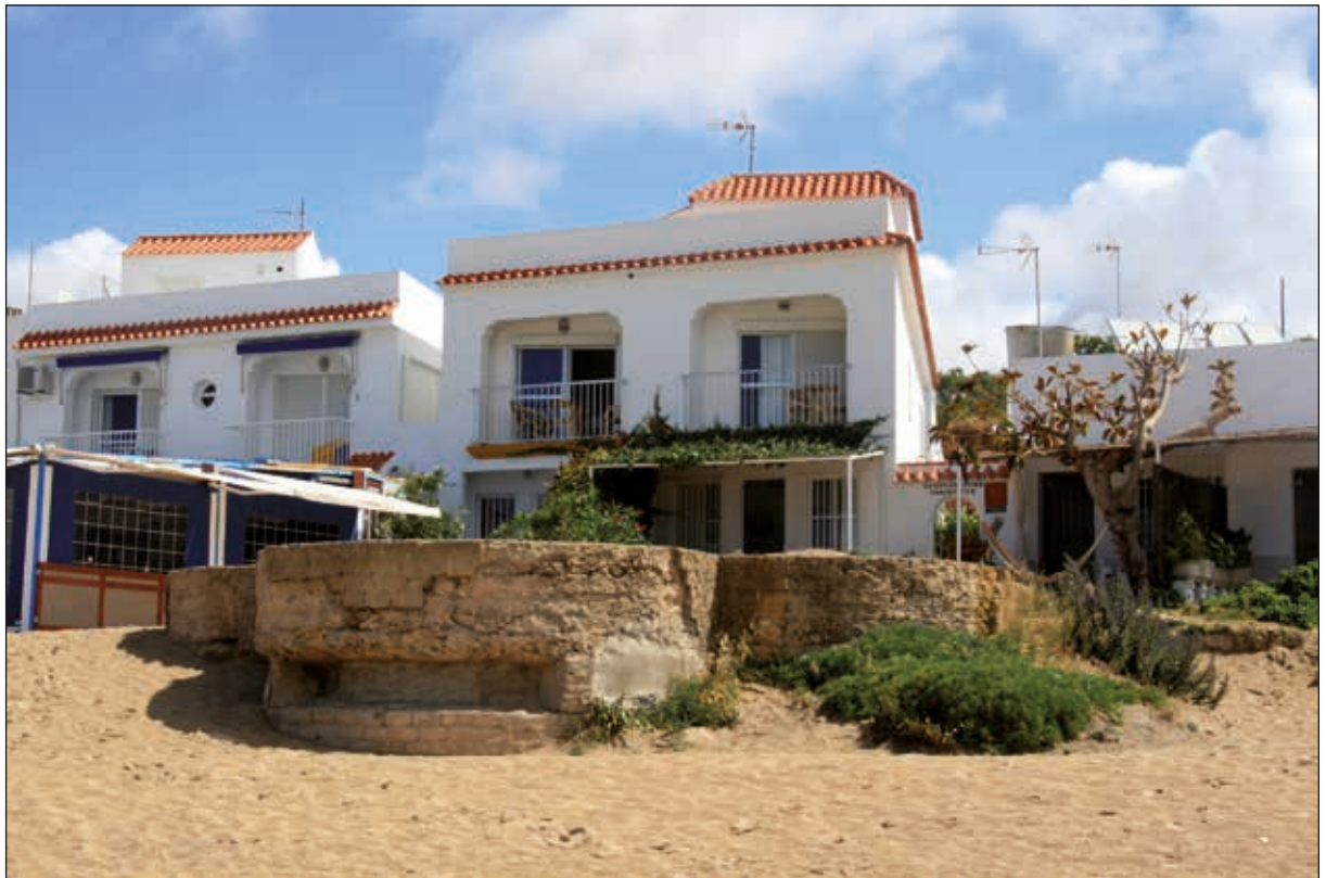
Lámina 12. (arriba). Obra compuesta tipo bloque 476 (obra IV-B-25) de Conil de la Frontera - Cádiz. Para un cañón anticarro y dos ametralladoras. AGMAV-M-2377-2 detalle
