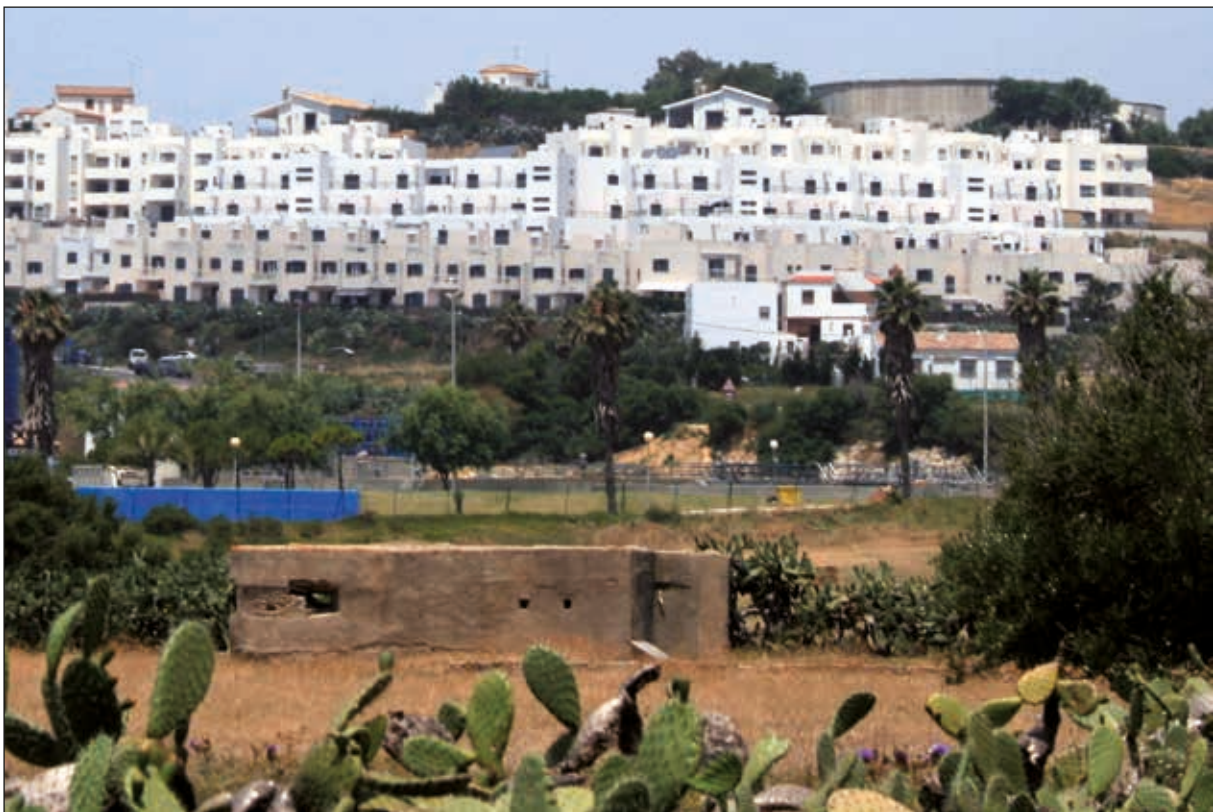
Lámina 10. (arriba). Nido de ametralladoras 472 (obra IV-B-24) de Conil de la Frontera - Cádiz. AGMAV-M-2377-2 detalle Lámina 11. (debajo). Nido de ametralladoras 472 (obra IV-B-24) de Conil de la Frontera - Cádiz, en 2010. Fotografía de A. Sáez
