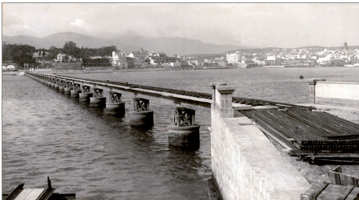
Lámina 8. El puente de la Isla Verde para el tren de obras en construcción. Año 1926 (Archivo Fotográfico de la A.P.B.A.)
