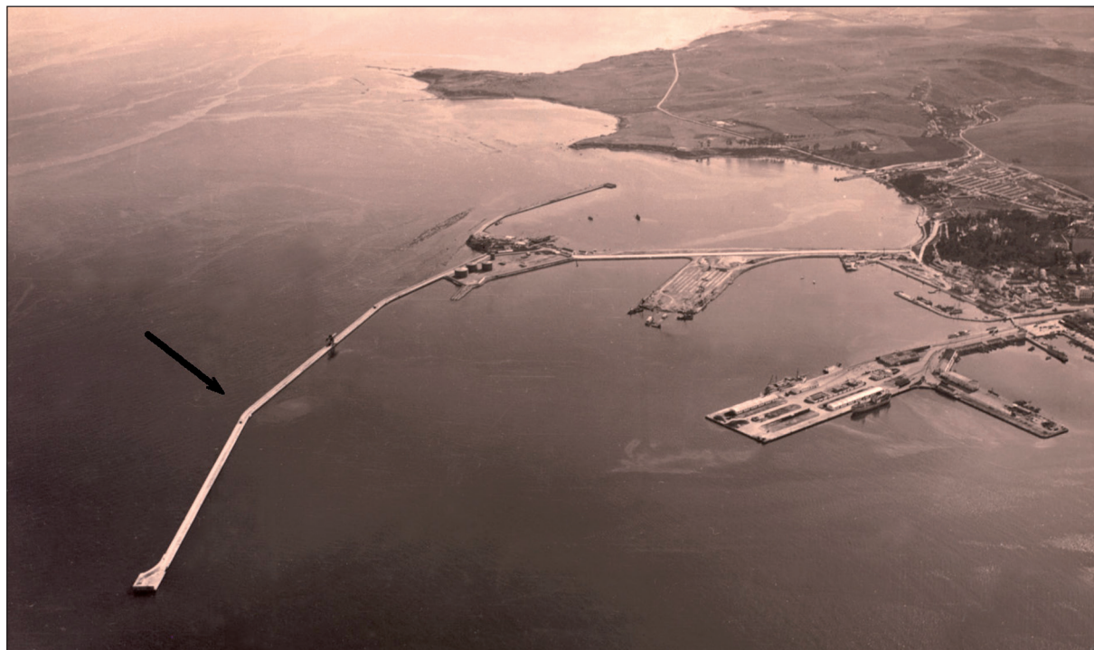
Lámina 16. Vista aérea del puerto. Año 1964. Véanse el acceso a la Isla Verde y el muelle de pasajeros y automóviles aún en obras. En la parte inferior derecha, los muelles de la Galera y Pesquero. Señalado con una flecha el Dique Norte y el “Titán”. (Archivo Fotográfico de la A. P. B. A.)
