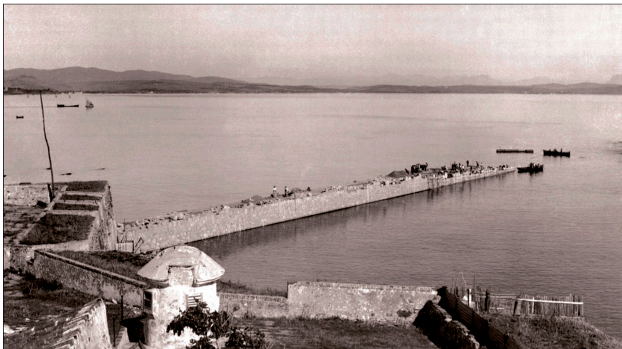
Lámina 5. Las obras del Rompeolas en sus inicios, antes de la instalación del "Titán" y el "Goliat". Año 1921. (Archivo Fotográfico de la A.P.B.A.)
