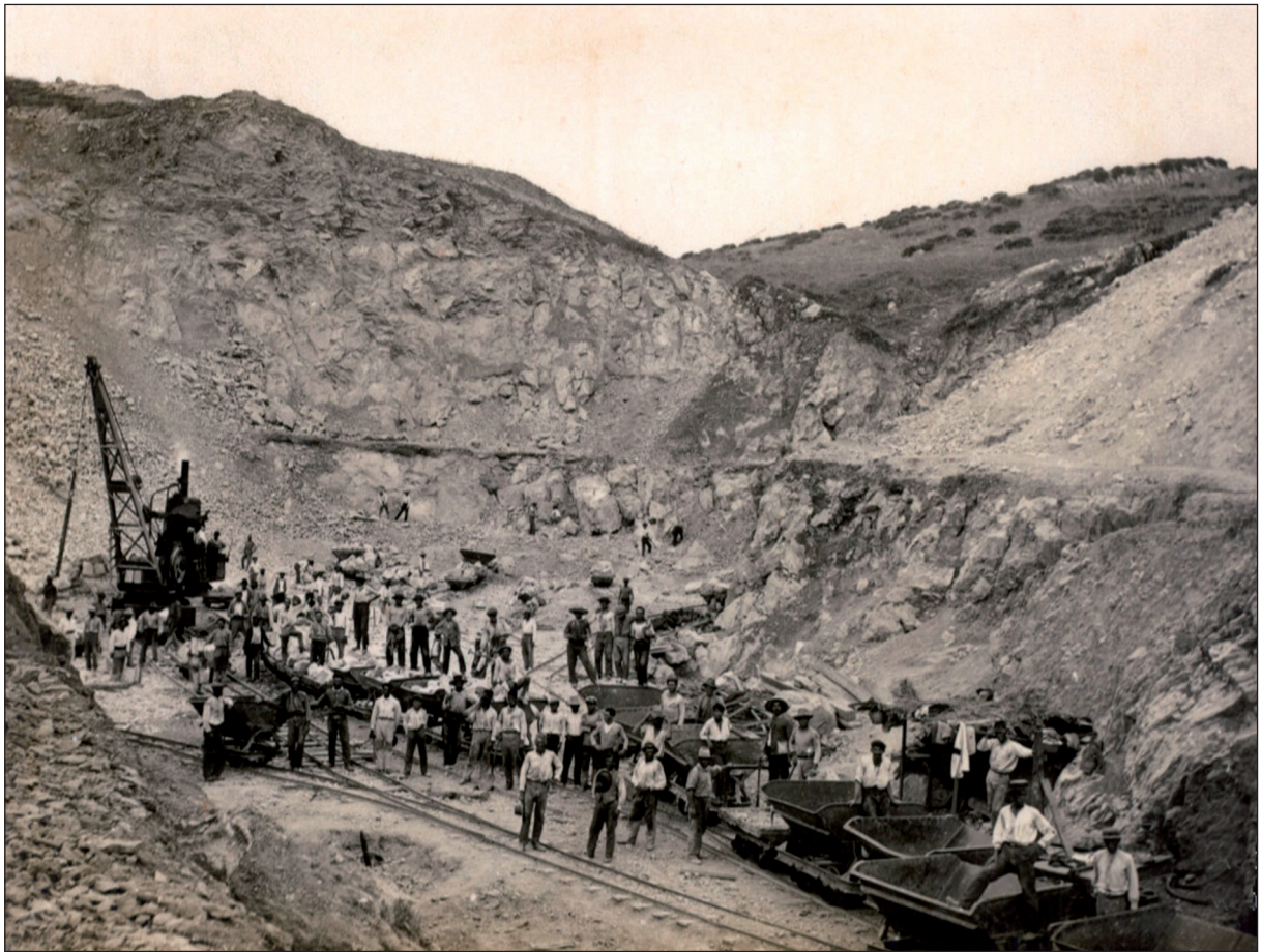
Lámina 6. La cantera de los Guijos y las vagonetas para el transporte de piedras. Hacia 1929 (Archivo Fotográfico de la A.P.B.A.)
