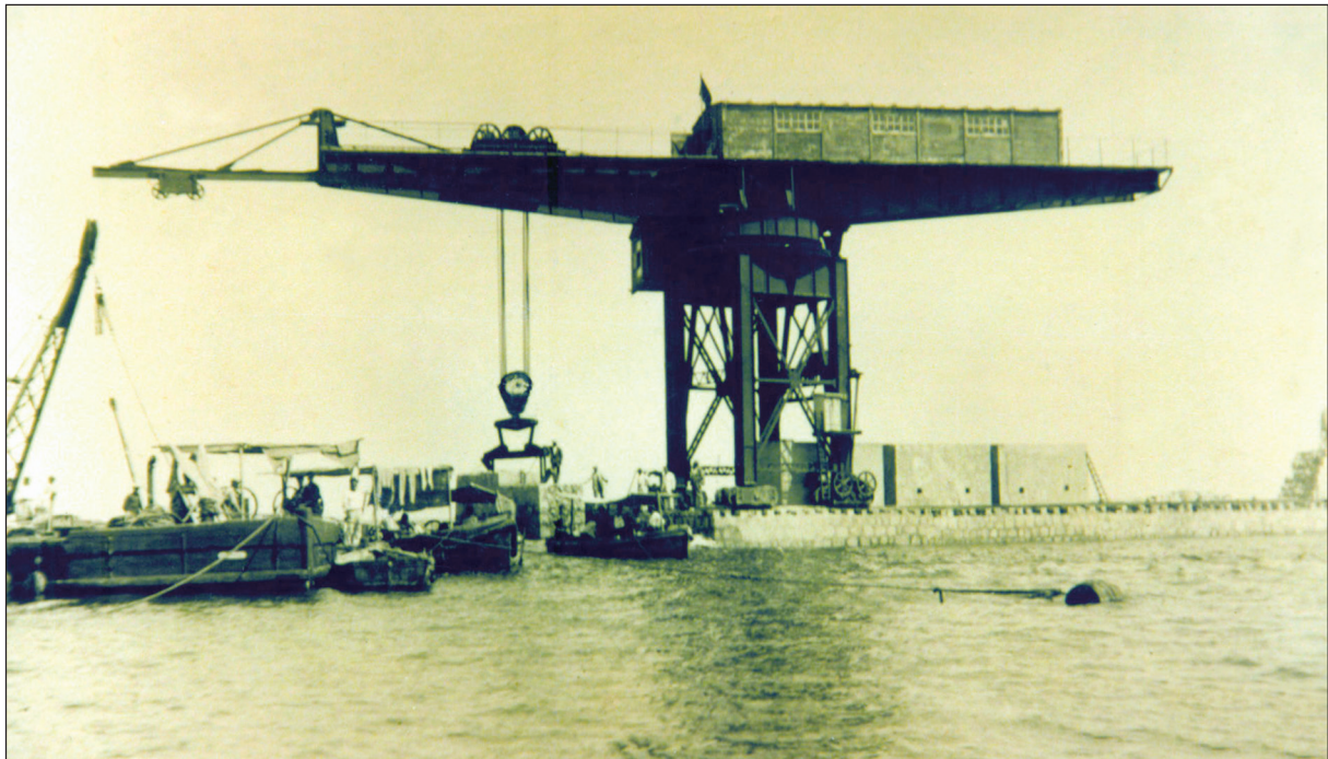
Lámina 9. El "Titán" colocando bloques en el extremo del Rompeolas en construcción. Hacia 1929 (Archivo Fotográfico de la A.P.B.A.)
