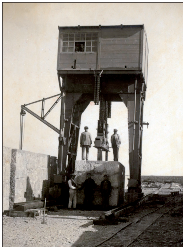
Lámina 10. La grúa-polipasto “Goliat” trasladando un bloque. Hacia 1927 (Archivo Fotográfico de la A.P.B.A.)
