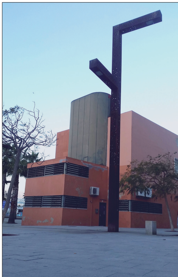
Lámina 1. Edificio del Cubo de la Música. Imagen de Juan Francisco Marín Sánchez
